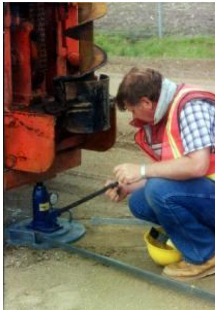
Εικόνα Β.1: Δοκιμή δοκιμαστικής φόρτισης πλάκας στο πεδίο.
