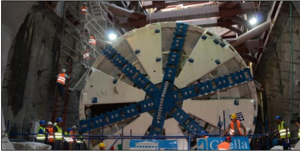
Εικόνα 2. 6. EPB – TBM κατά την επέκταση της Γραμμής 3 της Αττικό Μετρό προς Πειραιά (Πηγή: Αττικό Μετρό).
