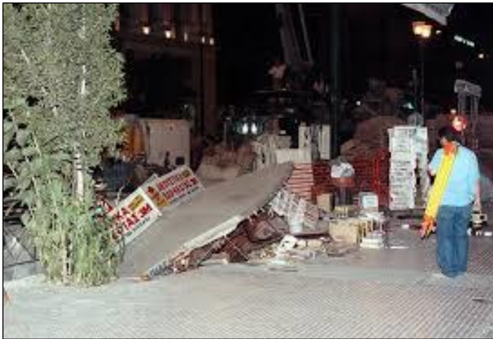
Εικόνα 1. 1. Κατάρρευση περιπτέρου επί της οδού Πανεπιστημίου, λόγω αστοχίας μετώπου της υποκείμενης σήραγγας Μετρό (Πηγή: tapea.gr ).
