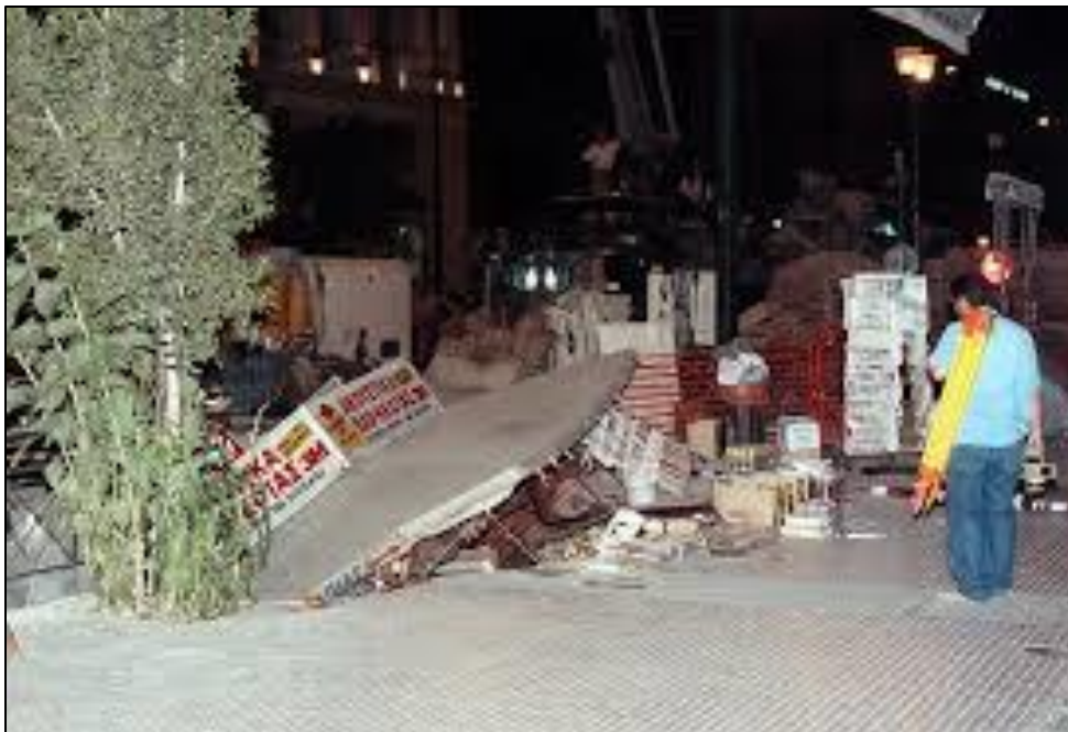
Εικόνα 3. 1. Επίδραση της κατασκευής της Γραμμής 2 του μετρό της Αθήνας σε επιφανειακή κατασκευή (Πηγή: tanea.gr).
