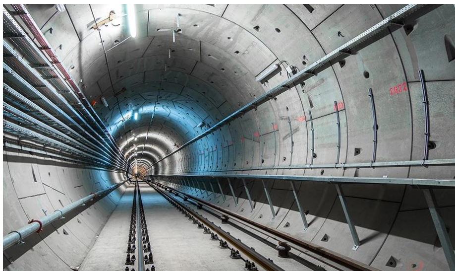
Εικόνα 2. 8. Επένδυση σήραγγας με προκατασκευασμένα στοιχεία - segments (Πηγή: Mesalmalat).
