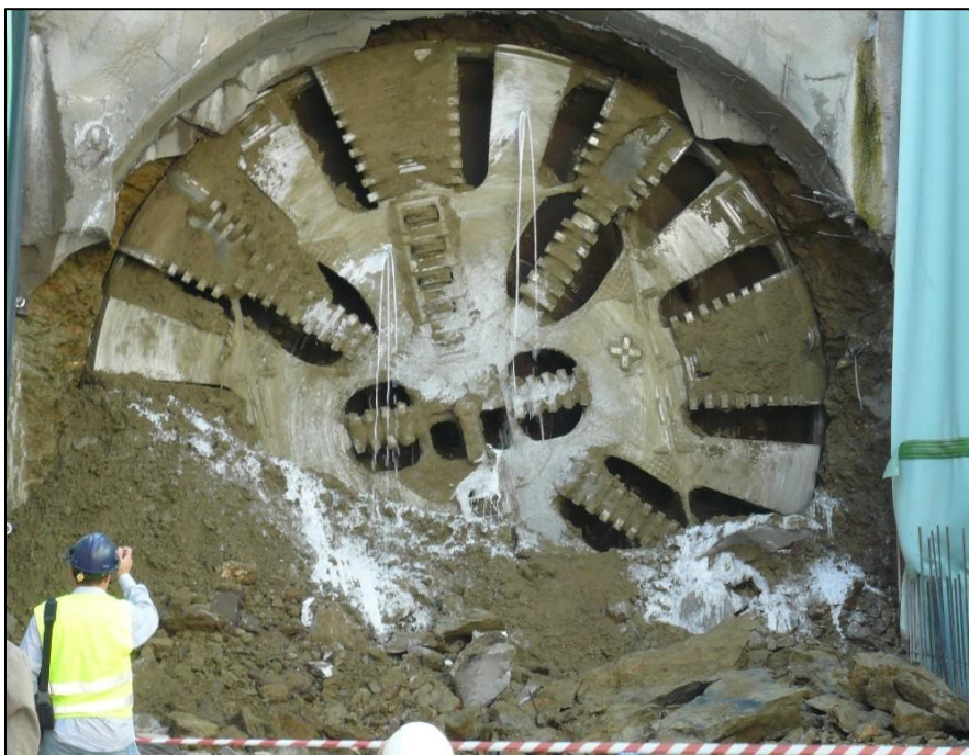
Εικόνα 6. 1. Μηχάνημα ολομέτωπης διάνοιξης σηράγγων (EPB – TBM) κατά την επέκταση της Γραμμής 2 προς Ελληνικό (Πηγή: ametro.gr).
