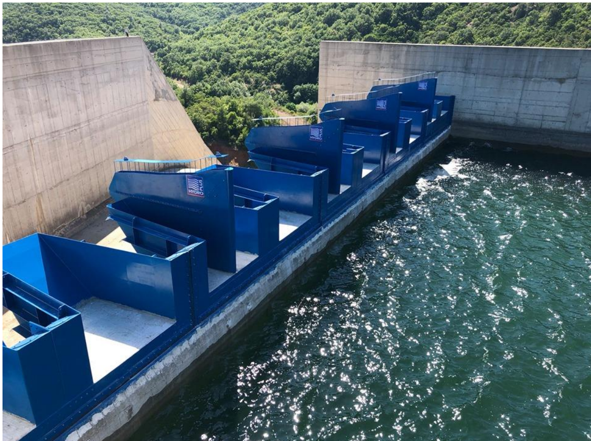
Σχήμα 1.2: Εικόνα από τα τοποθετημένα θυροφράγματα στον ταμιευτήρα Αισύμης της ΔΕΥΑΑ. (Πηγή: https://www.evros24.gr/ )
