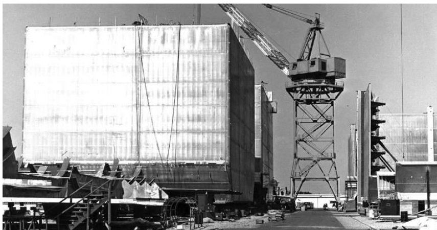
Εικόνα 10 - Δεξαμενές Conch πρισματικού τύπου, 1970 (Πηγή: SIGGTO/GIIGNL)
