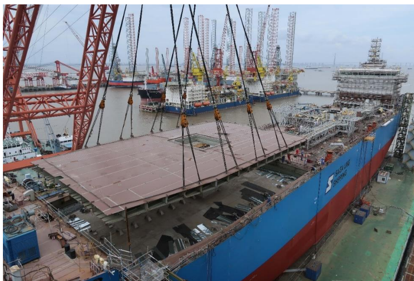
Εικόνα 16 - SAGA / LNT A-Box υπό κατασκευή, 2018 (Πηγή: LNG World News)
