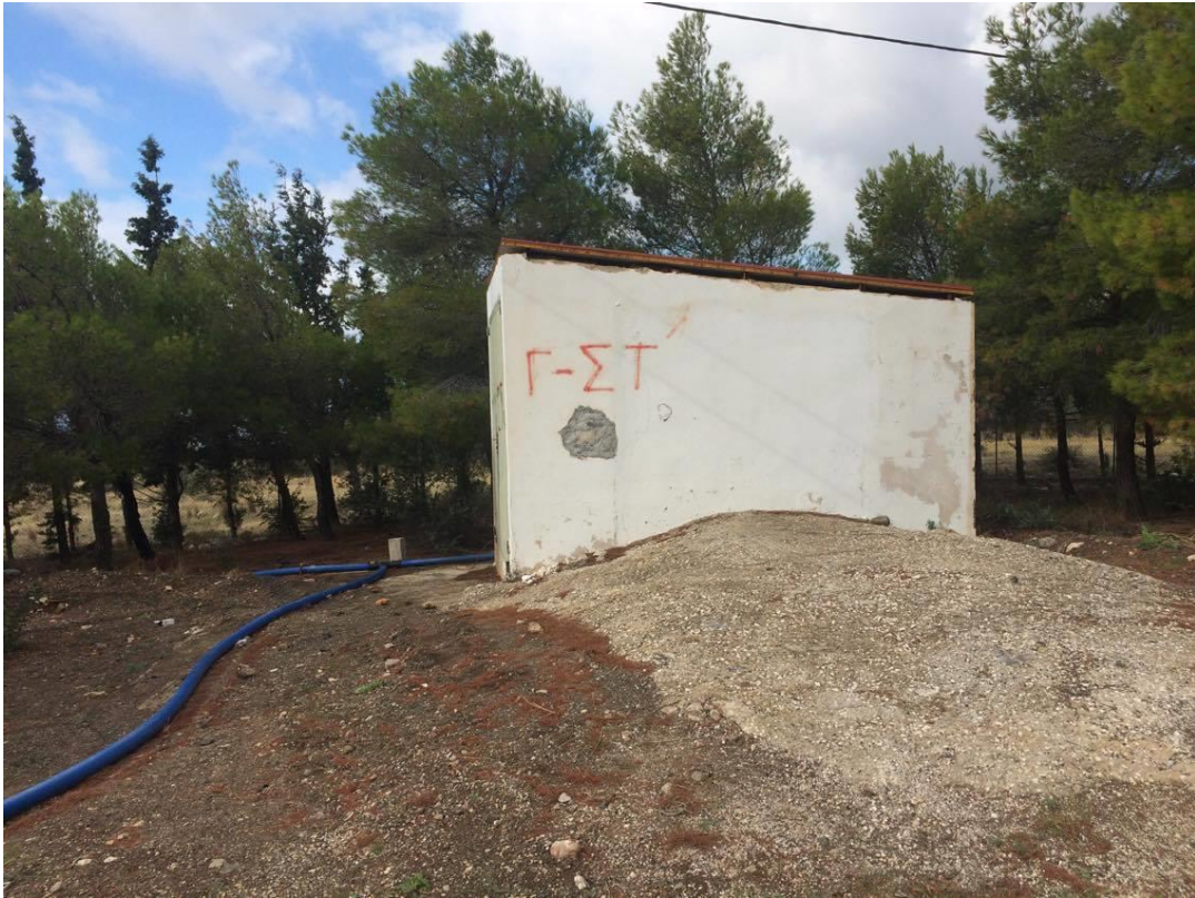
Εικόνα Π5 - Υδρευτική γεώτρηση στην περιοχή του Λουτρακίου.
