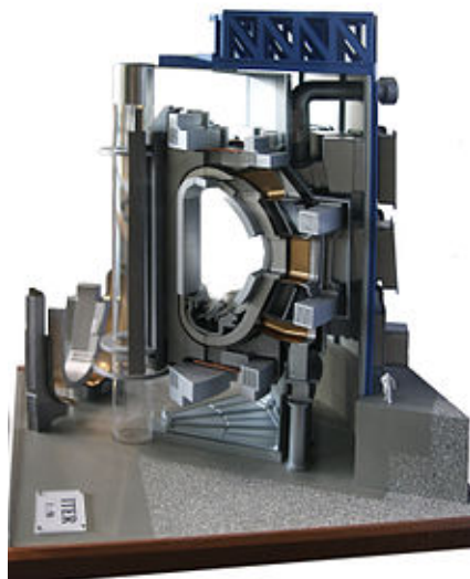
Σχήμα 1.10: Απεικόνιση τομής του τόρου του ITER
