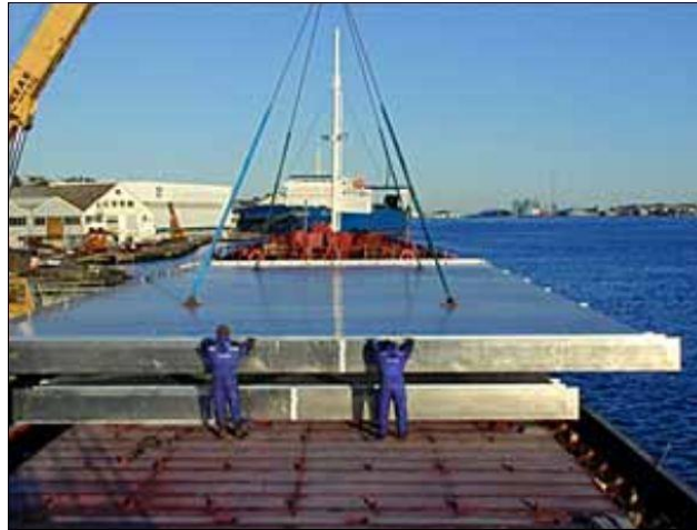
Εικόνα 24: Ενισχυμένα ελάσματα καταστρώματος προκατασκευασμένα με FSW, προορισμένα για το κρουαζιερόπλοιο «The World» (από [36]).
