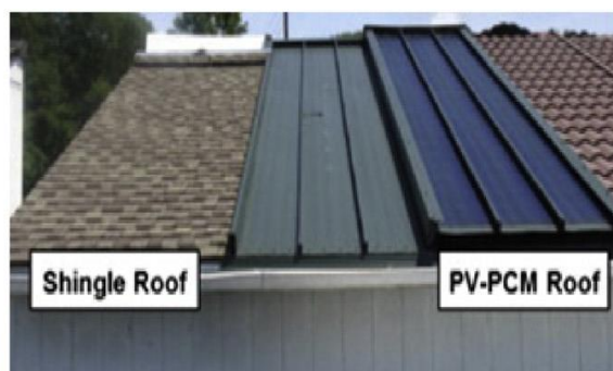
Εικόνα 5.2.7: Σύστημα PV-PCM οροφής [5.27].
