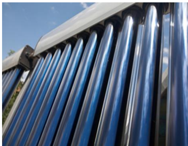
Εικόνα 2.4.3: Συλλέκτης αποτελούμενος από πολλούς σωλήνες κενού [2.15].
