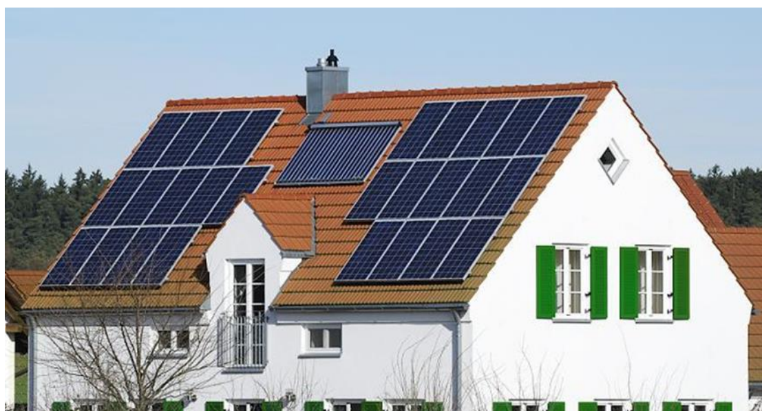
Εικόνα 2.5.1: Εγκατάσταση φωτοβολταϊκών σε στέγη [2.22].
