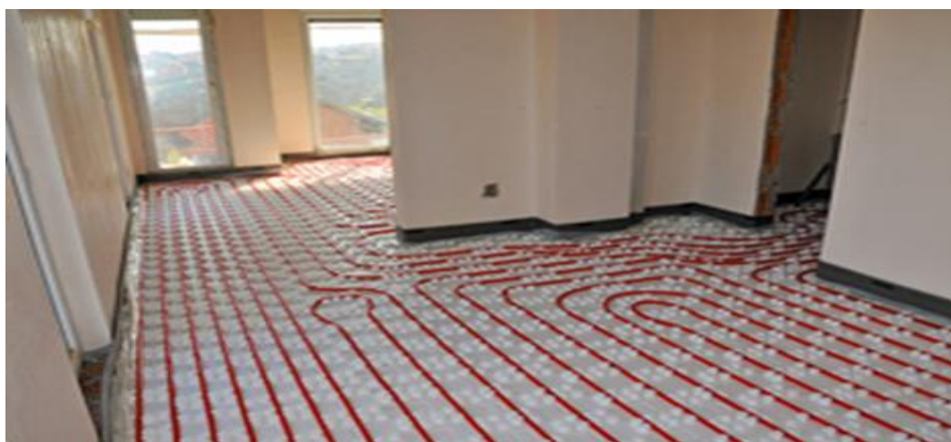
Εικόνα 3.1.1: Ενδοδαπέδιο σύστημα θέρμανσης [3.1].
