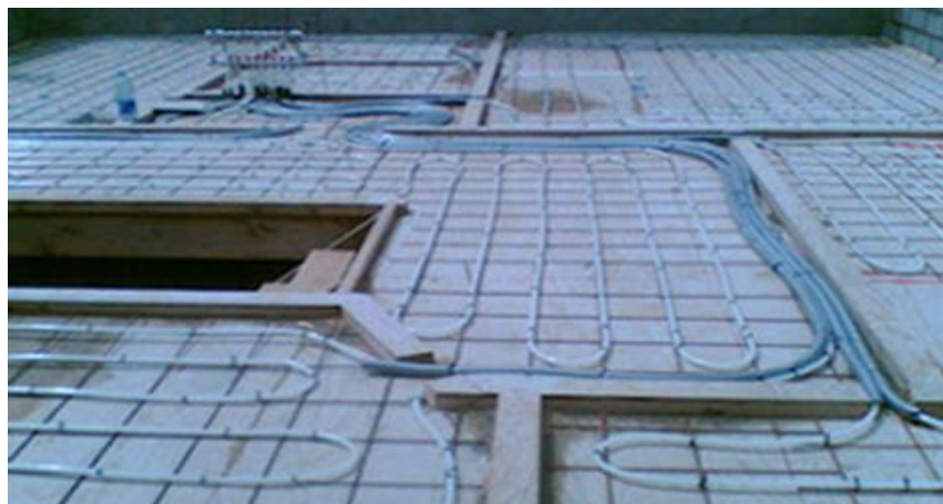
Εικόνα 3.2.6: Ενδοδαπέδιο σύστημα δροσισμού [3.1].
