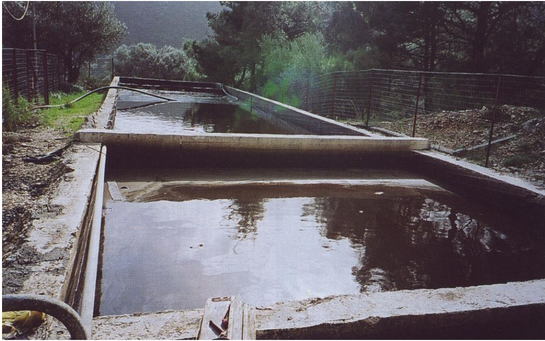
Εικόνα 1.4. Συλλογή κασιόγρου σε ανοικτές δεξαμενές (εξατμισιοδεξαμενές)
