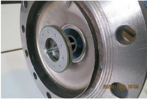
Απομάκρυνση αντεπίστροφης βαλβίδας και βαλβίδας ασφαλείας και διαμόρφωση νέας φλάντζας
