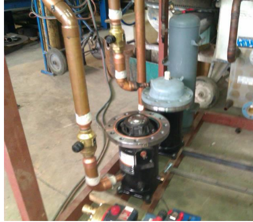
Απομάκρυνση αντεπίστροφης βαλβίδας και βαλβίδας ασφαλείας και διαμόρφωση νέας φλάντζας
