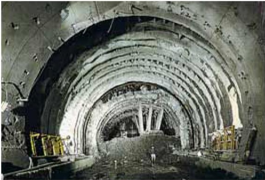
Εικόνα 2.2: Κατάρρευση του μετώπου και της κοιλότητας με εξαιρετικά μεγάλες συγκλίσεις [14].
