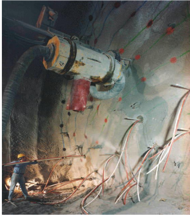
Εικόνα 3.1: Εγκατάσταση αγκυρίων fibreglass σε μέτωπο σήραγγας [15].
