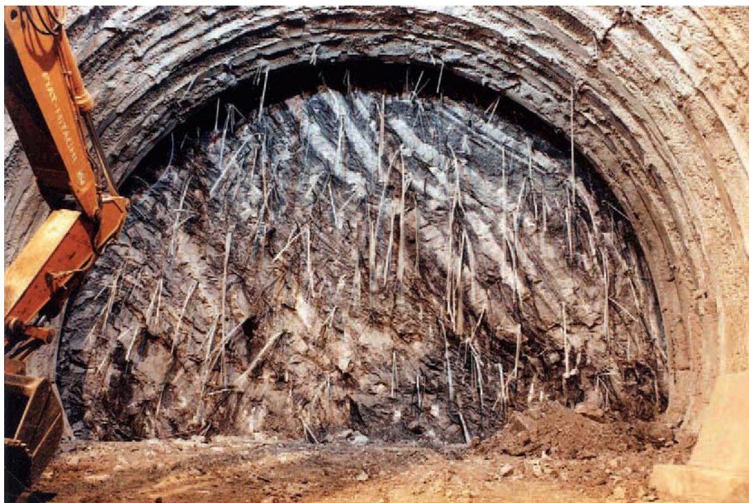
Εικόνα 3.7: Μέτωπο σήραγγας ενισχυμένο με οριζόντια αγκύρια fiberglass [15].
