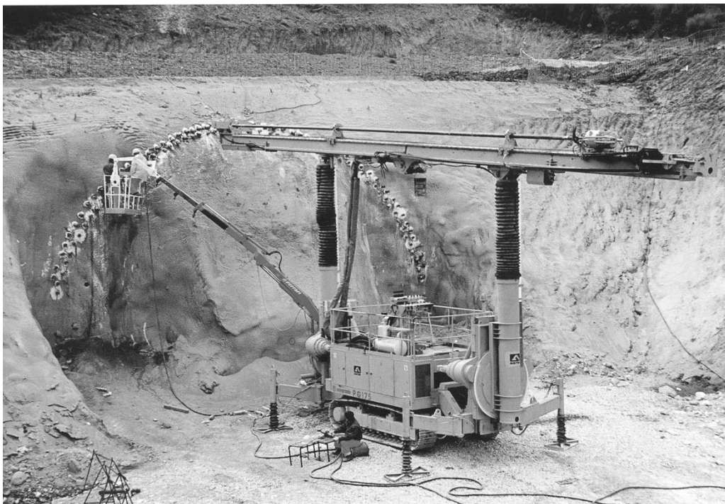
Εικόνα 3.5: Εγκατάσταση δοκών προπορείας σε στόμιο σήραγγας.
