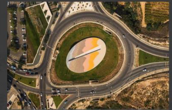
10. Διαμόρφωση Κυκλοφοριακού Κόμβου στην είσοδο της Πάφου
