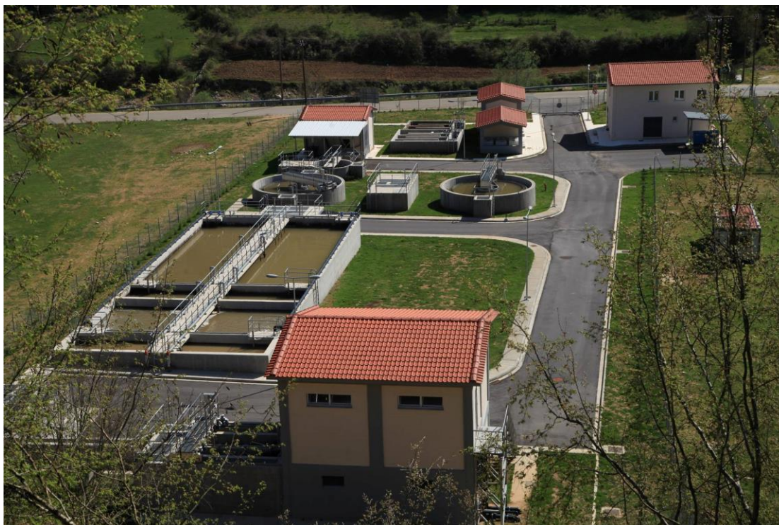
Εικόνα 39 Μονάδα επεξεργασίας λυμάτων οικισμού Εχίνου (© Χαμνή Χαλίλογλου)
