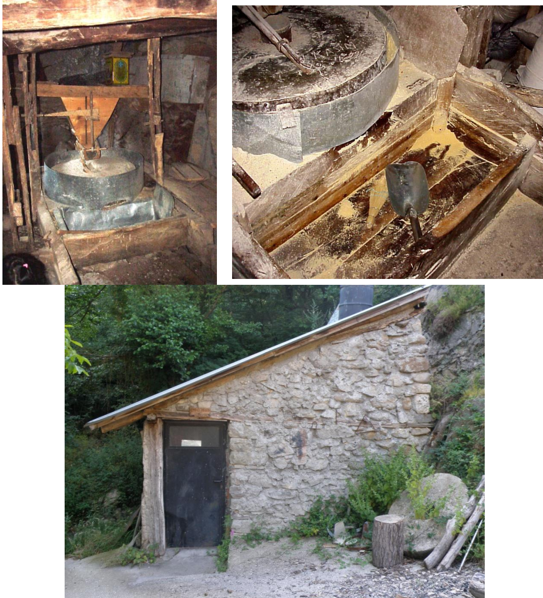
Εικόνα 26. Πάνω αριστερά: Ο νερόμυλος της Πάχνης, πάνω δεξιά: Η σκάφη και η μυλόπετρα στο νερόμυλο του παπά, κάτω: Εξωτερικά ο νερόμυλος της Πάχνης (πηγή επάνω εικόνων: http://pomakohoria.blogspot.com/2011/09/blog-post_6578.html , κάτω εικόνα: προσωπικό αρχείο Χοτζάρ Νεϊλάν).
