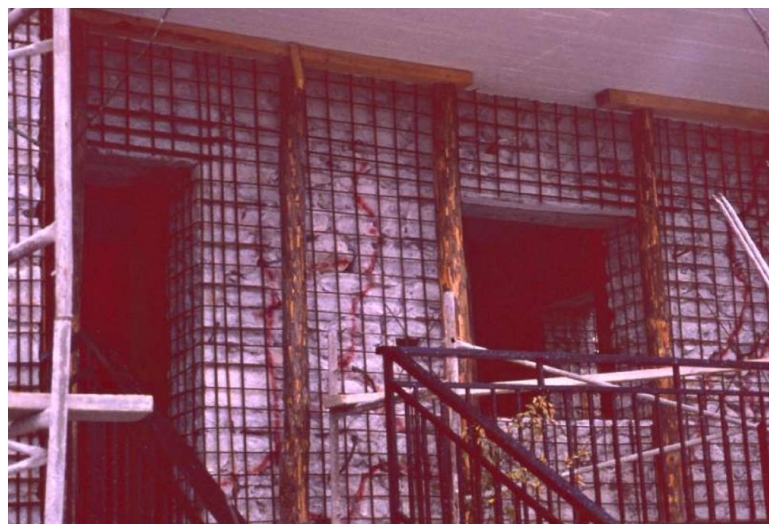
Εικόνα 6.3: Ενίσχυση Φέρουσας Τοιχοποιίας από Εκτοξευόμενο Σκυρόδεμα
