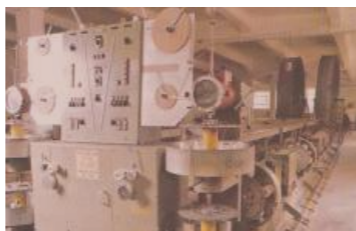
Εικ26 : Εξοπλισμός ΠΥΡΚΑΛ
