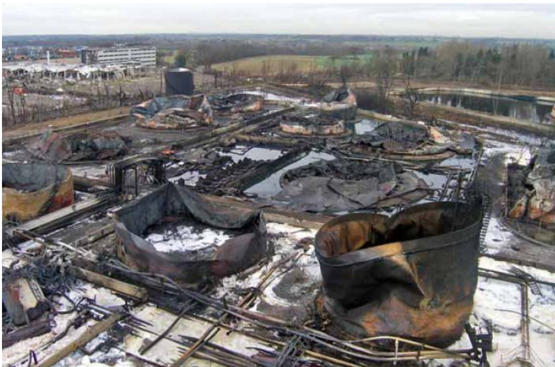
Εικόνα 3-3: Κατεστραμμένες δεξαμενές μετά την φωτιά.
