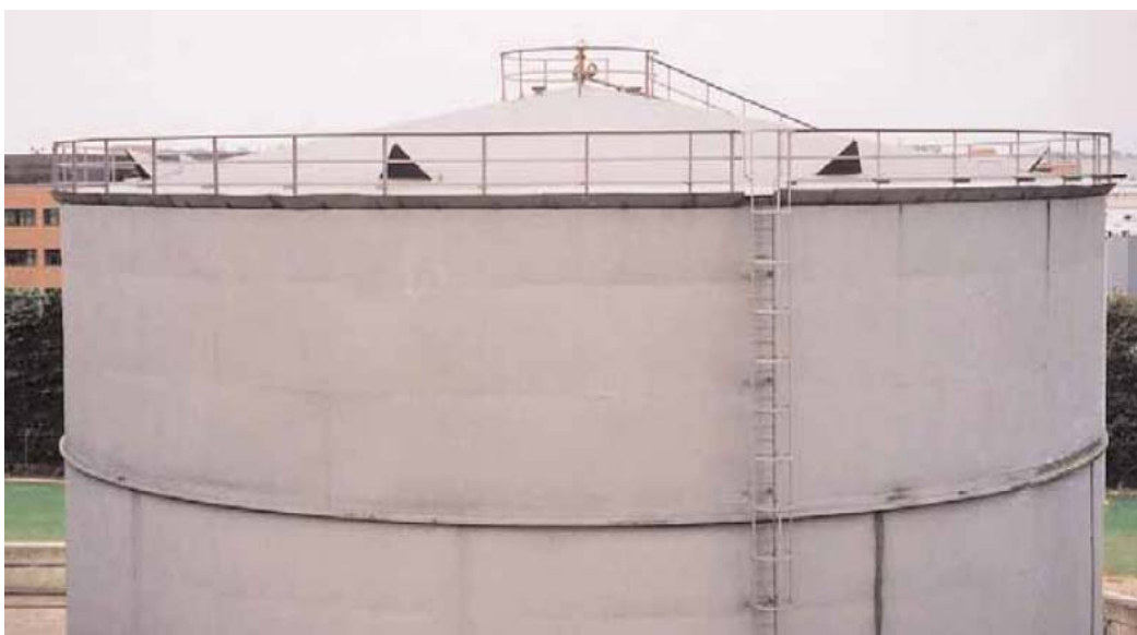
Εικόνα 3-14 : Λεπτομέρειες δεξαμενής 912 αμέσως μετά την κατασκευή της (HSE, Buncefield MIIB, 2006c).
