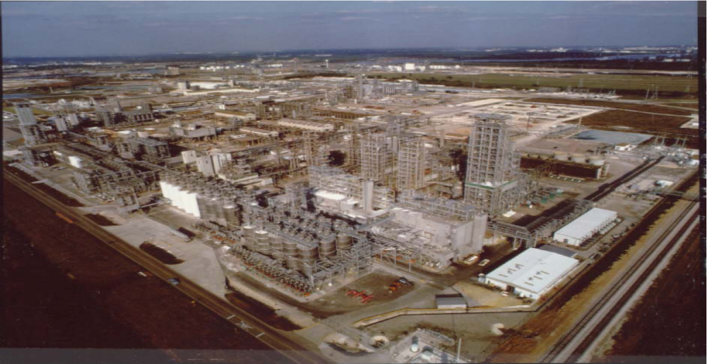
Εικόνα 2-1: Αέρια λήψη των εγκαταστάσεων της Phillips πριν από την έκρηξη ( FEMA technical report, 1998 ).
