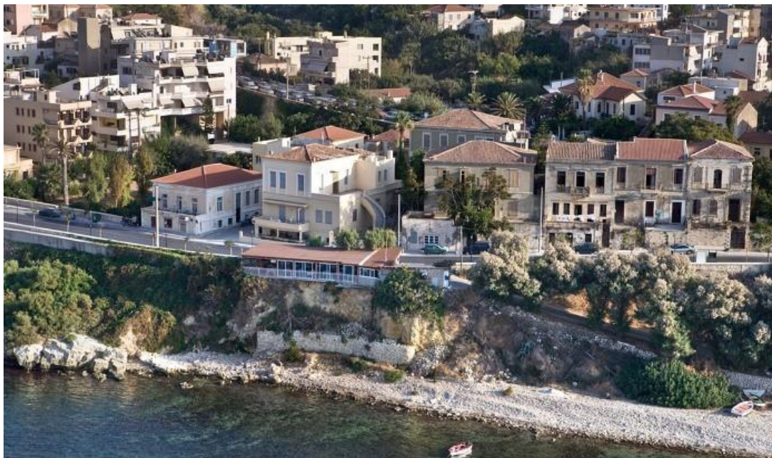
Σειρά Νεοκλασικών κτιρίων στο παράλιο μέτωπο της περιοχής
