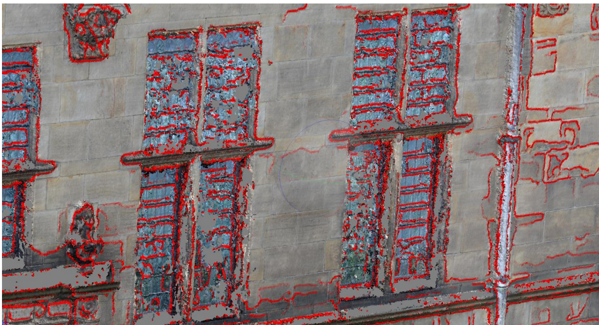
Εικόνα 6.4 : Δημιουργία προβληματικών περιοχών εντός των παραθύρων και έντονου θορύβου στο τείχος της κατασκευής
