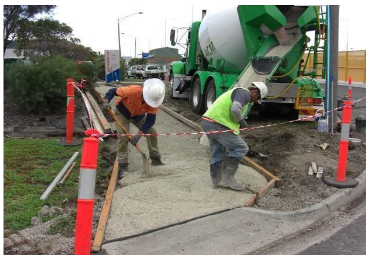
Σχήμα 2.5: Τοποθέτηση γεωπολυμερικού σκυροδέματος στην Αυστραλία
