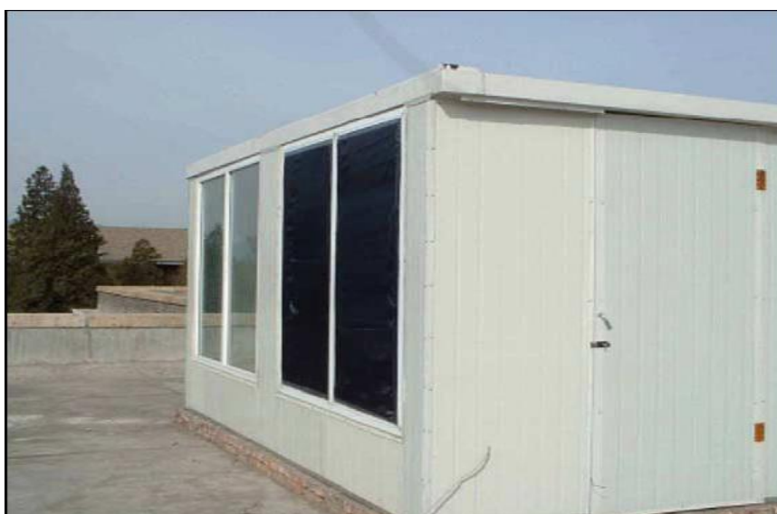
Σχήμα 5.18: Απεικόνιση του πειραματικού σπιτιού με shape-stabilized πλάκες με PCM[20].
