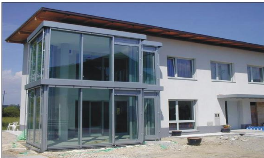
Σχήμα 4.13: Χαμηλής απαίτησης ενέργειας σπίτι με ενσωματωμένη μονάδα αποθήκευσης λανθάνουσας θερμότητας στη Σλοβενία [20].
