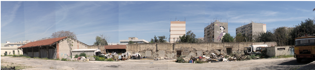
Το κτίριο B2
