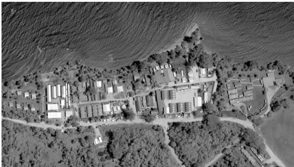
Εικ.21 // Αεροφωτογραφία της δομής στη νήσο Μανούς // Τυχόν σχέδια δεν είναι διαθέσιμα στο ευρύ κοινό, πηγή: https://www.abc.net.au/news/2014-04-29/manus-island-regional-processing-centre-aerial-interactive-image/5415560?nw=0
