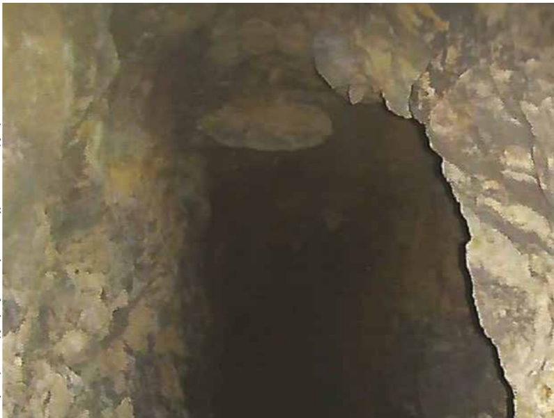
σήραγγα προς φρέαρ αερισμού_χούφης σκυροδετημένα τοιχώματα 1
