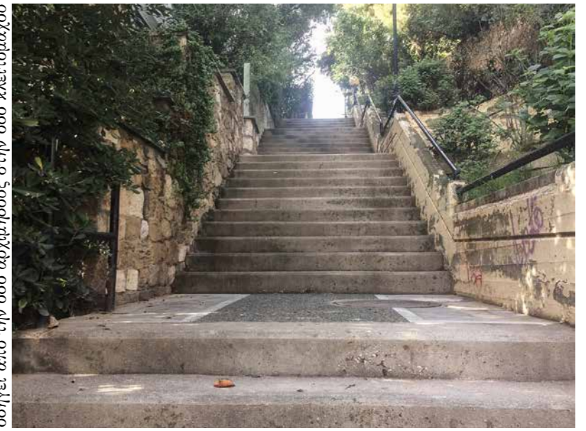
σκάλα που οδηγεί από την οδό αρχιμήδους στην οδό κλειτομάχου
