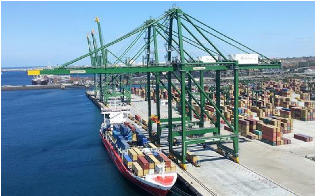
Εικόνα 19 Φορτοεκφόρτωση στο κρηπίδωμα με γερανογέφυρα 71
