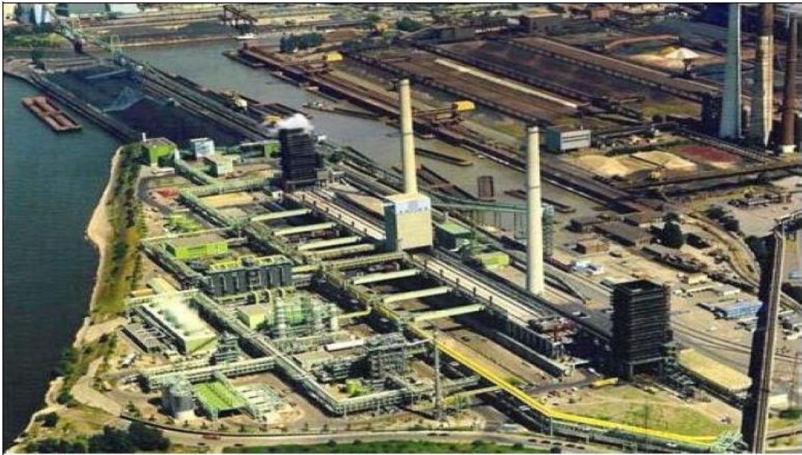
Σχ. 2.2. Φωτογραφία μονάδας παραγωγής κοκ στο Duisburg-Schwelgern, Γερμανία [19]
