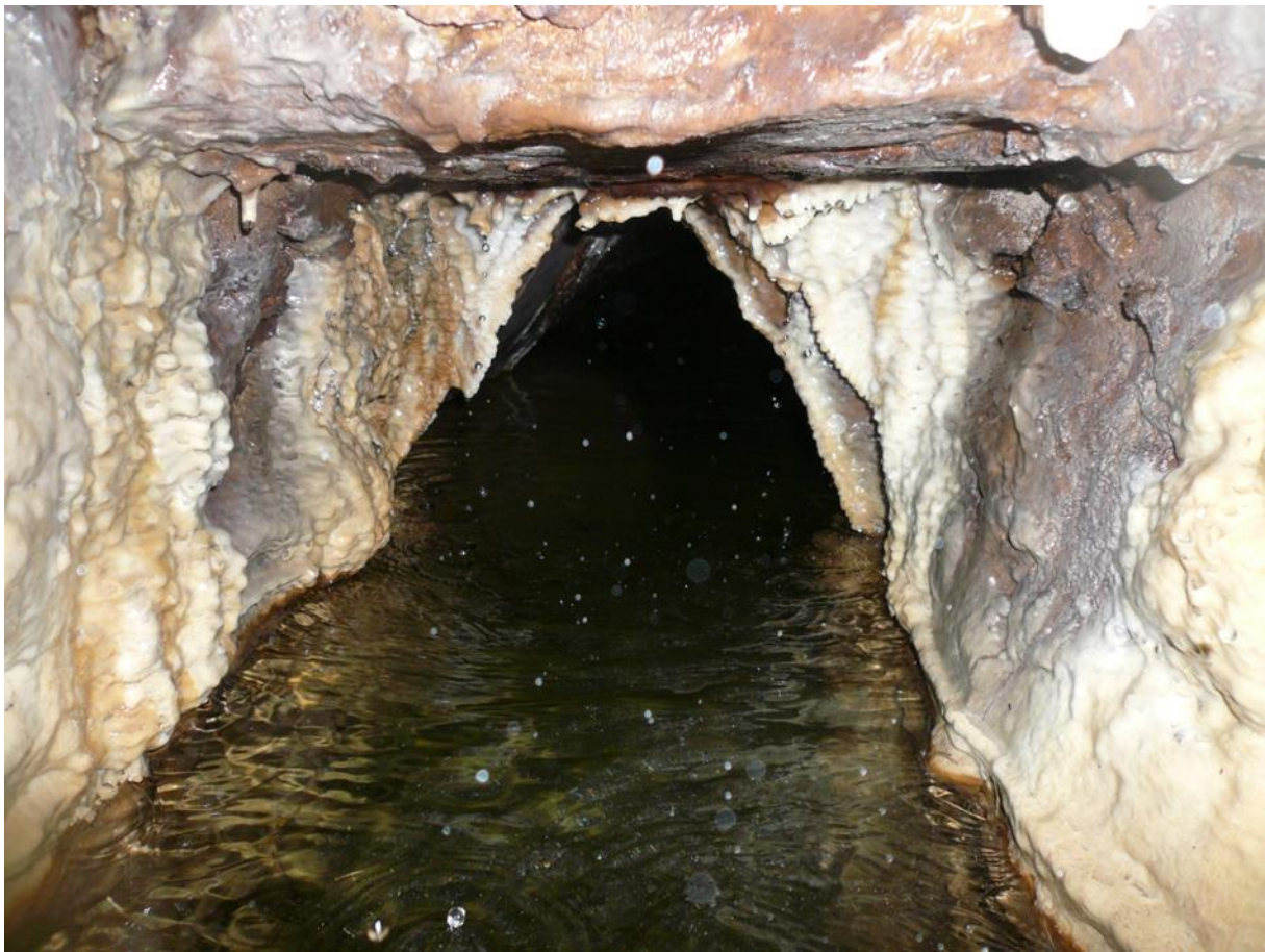
Εικόνα 2. 1 Εσωτερικό υδρομαστευτικής σήραγγας, Αδριάνειο Υδραγωγείο (Δευτεραίος, 2014)
