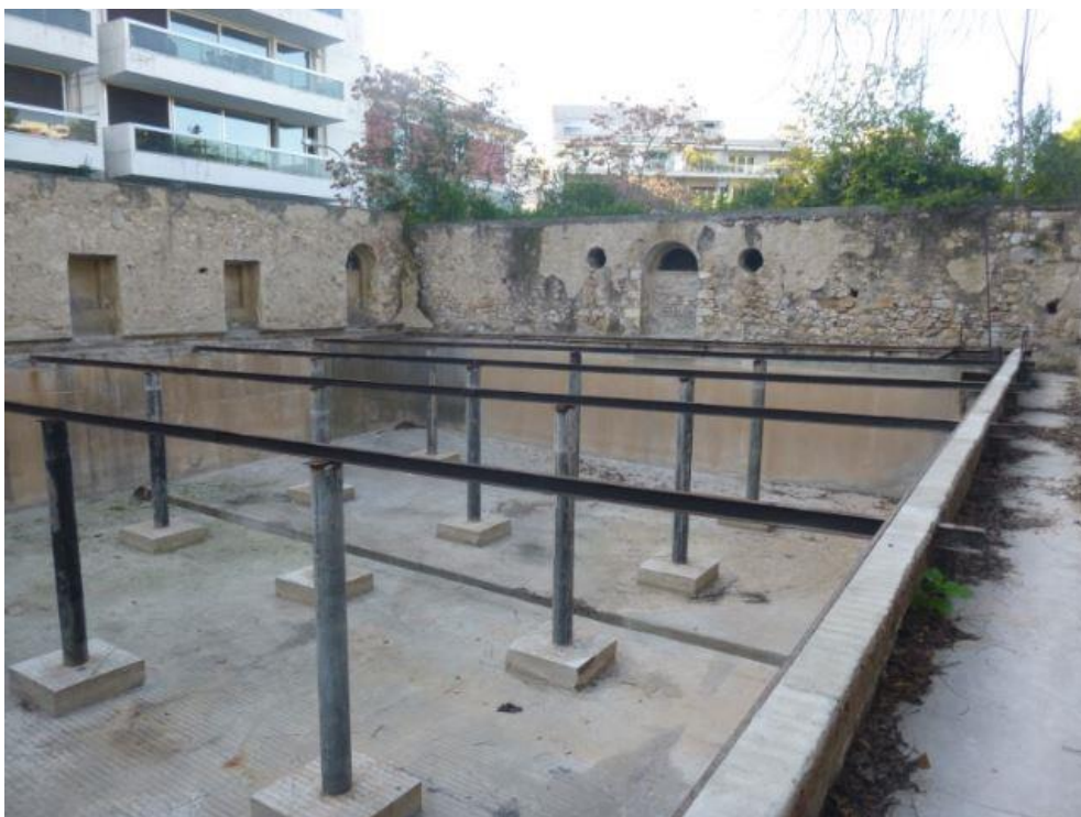
Εικόνα 5. 3 Σύγχρονη δεξαμενή του 1880 πλησίον ρωμαϊκής δεξαμενής (Δευτεραίος, 2019)
