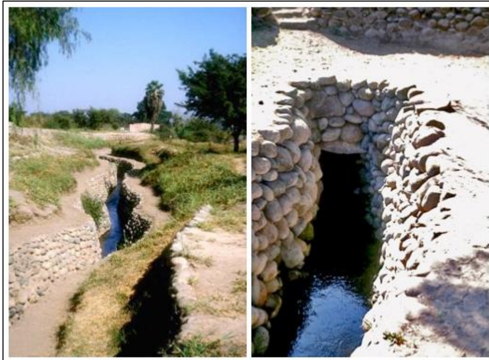
Εικόνα 2. 12 Κατάντη τμήμα των Ruqiyos όπου το νερό ρέει σε ανοιχτό κανάλι (Proulx, 2008)
