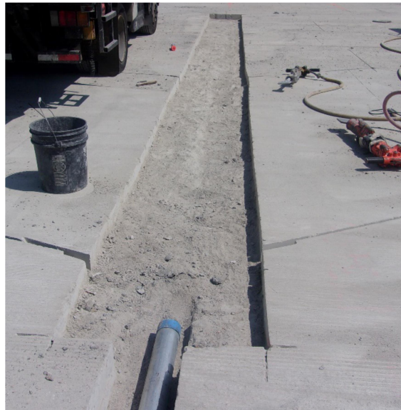
Εικόνα 1.8: Εκσκαφή του εδάφους για τοποθέτηση καμπτόμενων πλακών
