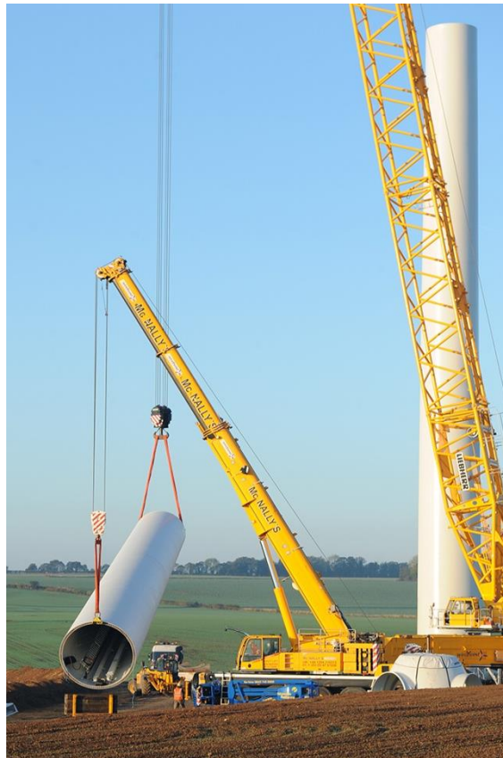
Σχήμα 2-27: Ανέγερση με χρήση γερανών (Πηγή:www.wind-science.org)
