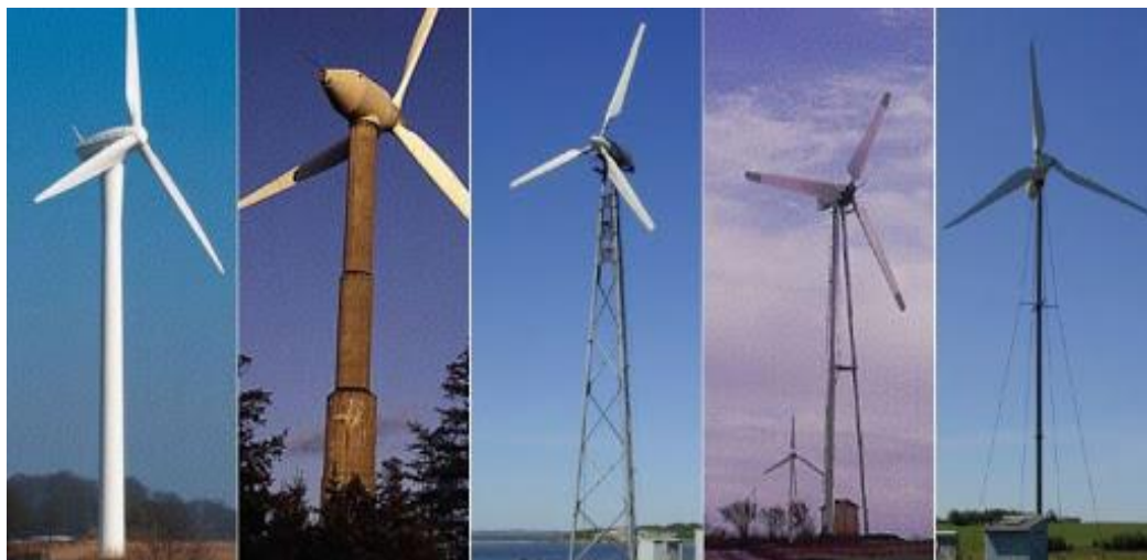
Σχήμα 2-6: Κύρια είδη πυλώνων ανεμογεννήτριας (Πηγή:www.steelwindtower.com)
