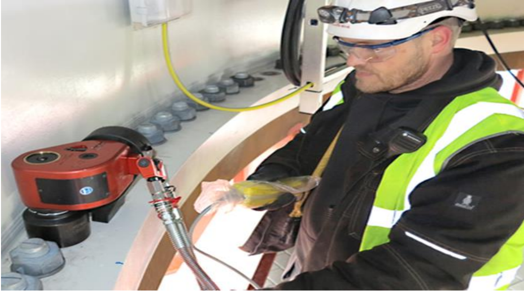
Σχήμα 2-26: Σύσφιγξη προεντεταμένων κοχλιών (Πηγή:www.ith.com)
