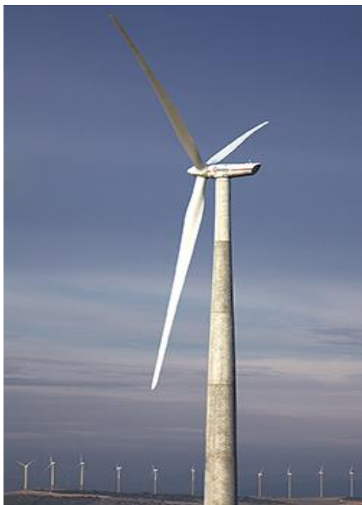
Σχήμα 2-3: Πυλώνας ανεμογεννήτριας από ωπλισμένο σκυρόδεμα (Πηγή: www.windpowerengineering.com )
