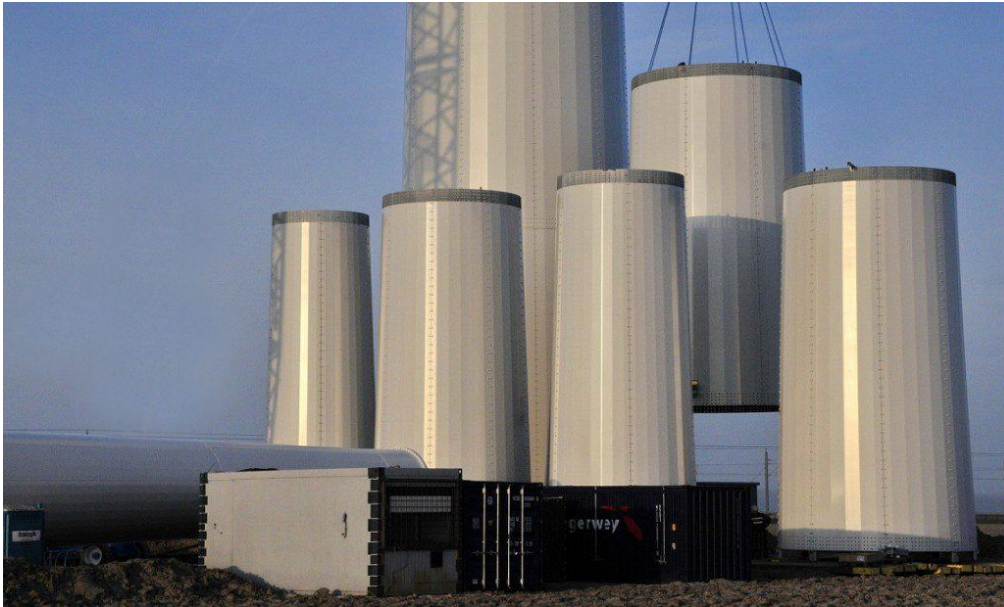
Σχήμα 2-7: Επιμέρους τμήματα αυτόνομων χαλύβδινων σωληνωτών πυλώνων (Πηγή:www.lagerwey.com)
