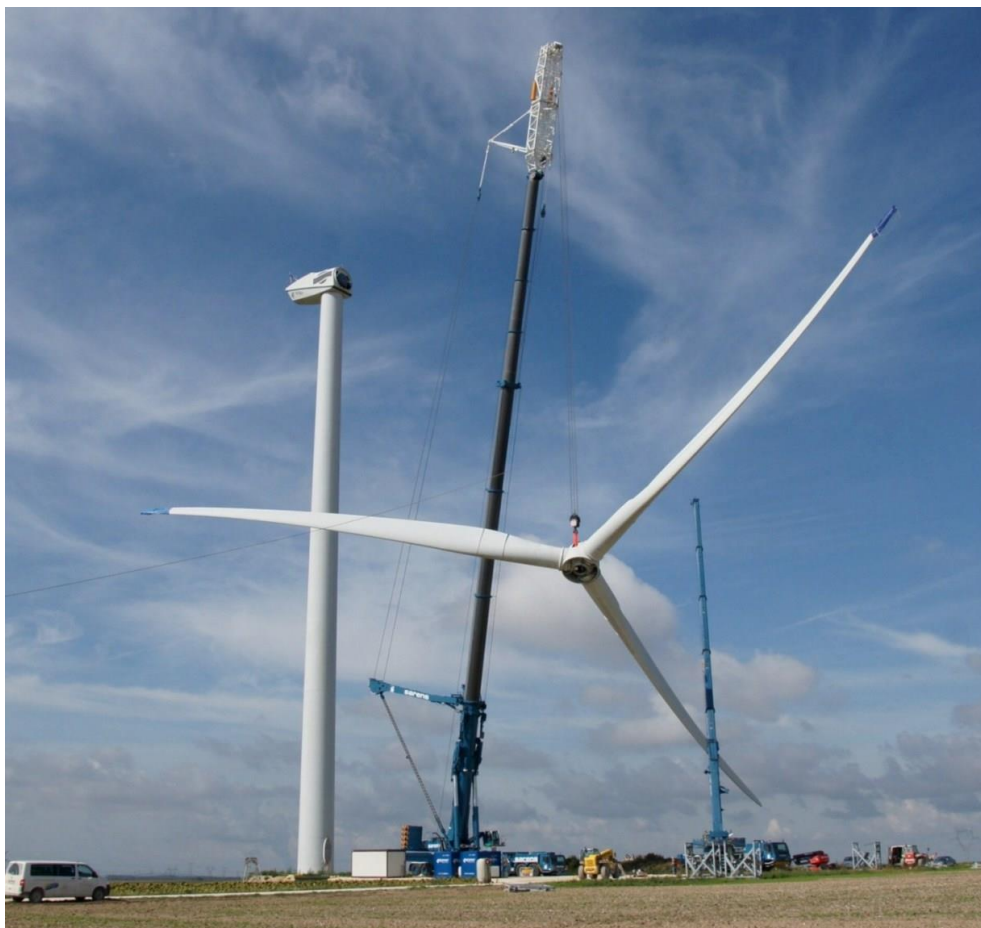
Σχήμα 2-29: Ανέγερση πτερυγίων (Πηγή:www.sarens.com)
