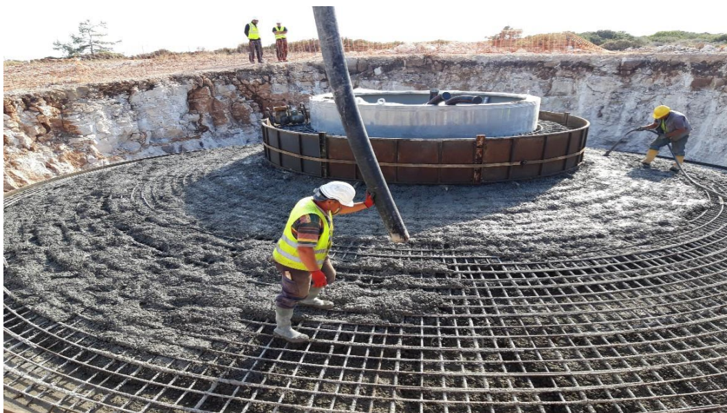
Σχήμα 2-24: Διαδικασία σκυροδέτησης θεμελίου ανεμογεννήτριας (Πηγή: www.hellinikimeletitiki.gr )
