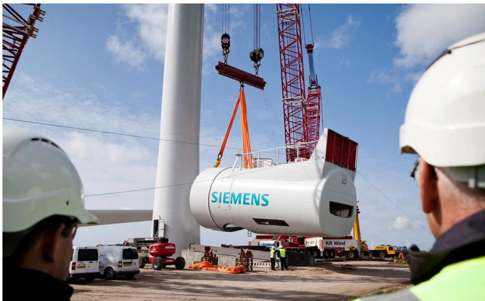
Σχήμα 2-28: Ανέγερση ατράκτου (Πηγή:offshorewindindustry.com)
