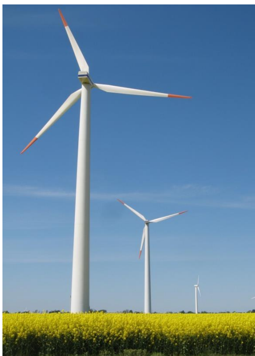
Σχήμα 2-4: Αυτόνομοι χαλύβδινοι σωληνωτοί πυλώνες ανεμογεννητριών (Πηγή: www.wikipedia.org )
