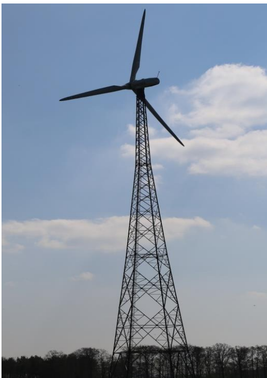
Σχήμα 2-1: Δικτυωτός πυλώνας ανεμογεννήτριας (Πηγή:www.en.wind-turbine-models.com)
