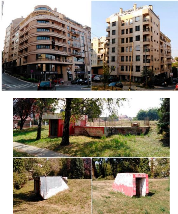
Εικόνα 1.49: Περίπλοκο κτήριο εφαρμογής (πάνω) & υπόγειο καταφύγιο (κάτω) Πηγή: Nenad Višnjevac, 2019
