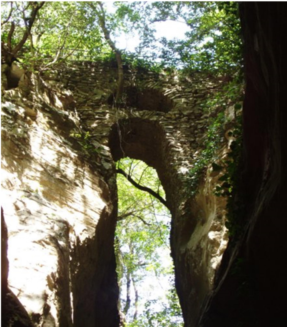
Το πέτρινο Πηγαδιώτικο γεφύρι, έχει δύο τόξα, το ένα πάνω από το άλλο, ενώνοντας τις όχθες του φαραγγιού Ριντόμου.
