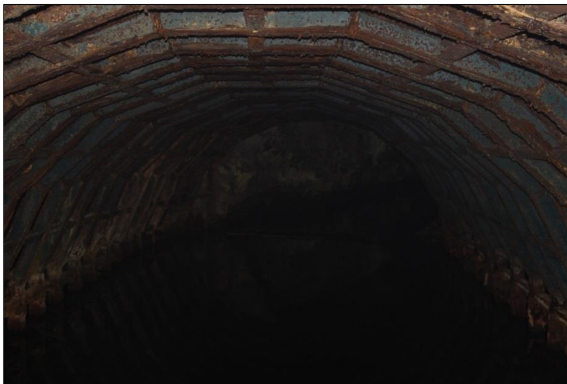
Εικόνα XX: Σιδηροκατασκευή σπηλαίου K2 [5].
