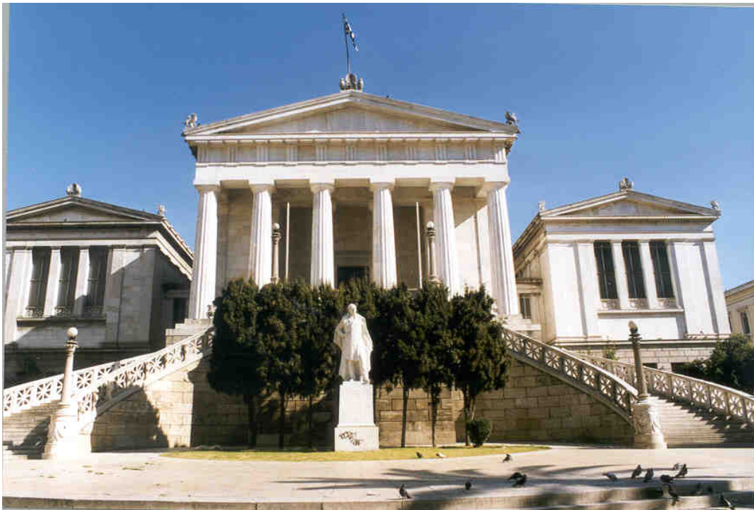
Εικ. 5.1.2 Η πρόσοψη του ιστορικού κτιρίου της Εθνικής Βιβλιοθήκης της Ελλάδος σήμερα
