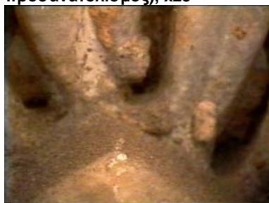
φαιόμαυρη κρούστα, κιονόκρανο, κεντρικό τμήμα, (ανατολικός προσανατολισμός), x100
