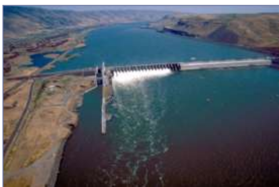
3-1-Φράγμα John Day στο Όρεγκον των ΗΠΑ , 16X135MW στρόβιλοι, συνολικής ισχύος 2.160MW[U.S. Army Corps of Engineers ]
