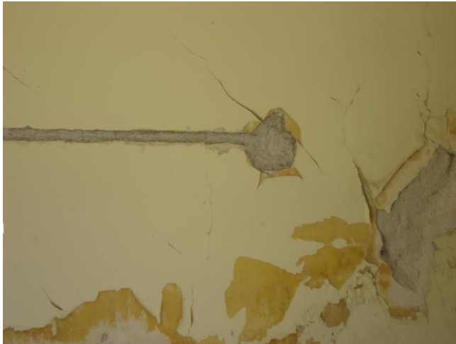
Εικόνα 3.3.2.11 Ισόγειο, νότια εξωτερική τοιχοποιία, χαμηλό ύψος, δεξί άκρο. Τοιχοποιία της λέσχης.
