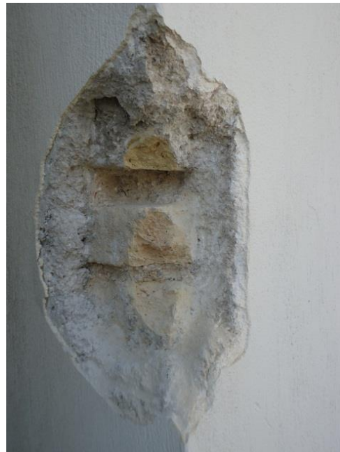
Θέση 1 2 ου ορόφου μετά τη δειγματοληψία
