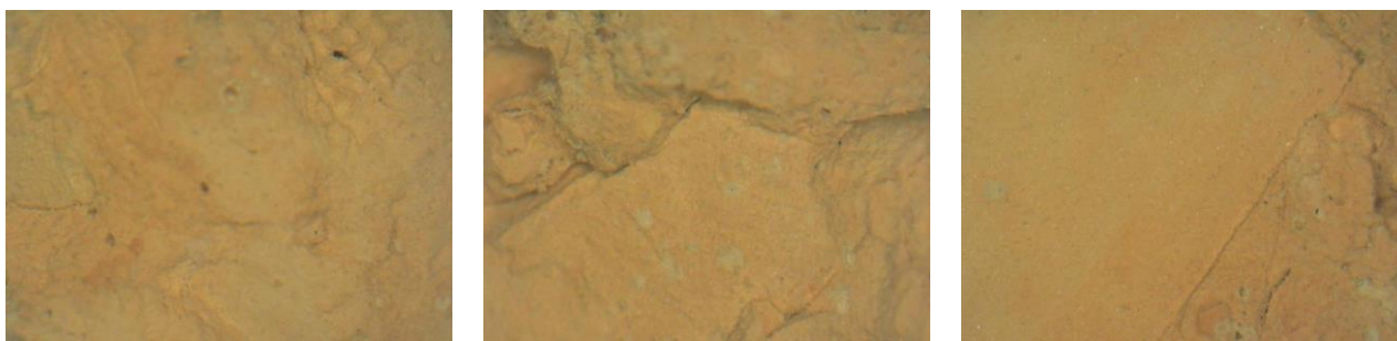
D11_cy: Κίτρινος οπτόπλινθος θέσης 1 1 ου ορόφου x50, x50, x50
