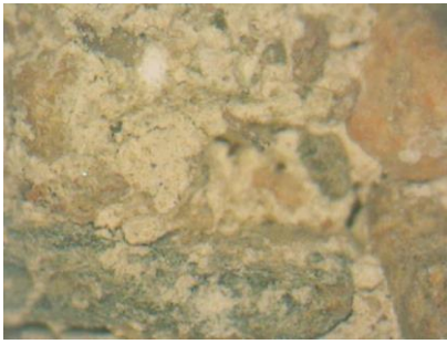
υπόστρωμα επιχρίσματος 2 ου ορόφου (FOM x50)
