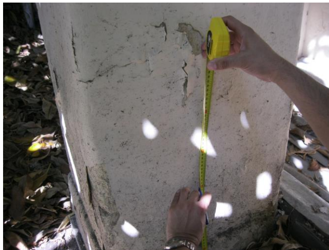
Εικόνα 3.3.2.13 Ισόγειο, κολώνα στην περιοχή της αυλής μπροστά από τον φεγγίτη του Υπογείου
