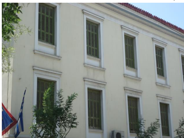
Περιοχή θερμογραφήματος 10, βόρεια όψη Οικίας, υπό γωνία
