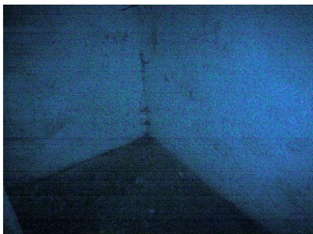
Περιοχή θερμογραφήματος 25 – Υπόγειο – Δυτική τοιχοποιία (αριστερά) με εγκάρσιο τοίχο (δεξιά)
