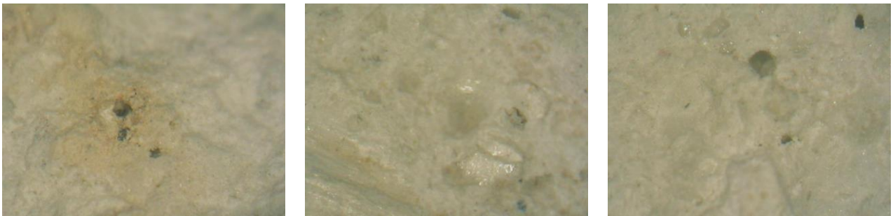
D23_sw: Υπόλευκος λίθος θέσης 3 2 ου ορόφου x50, x50, x50
