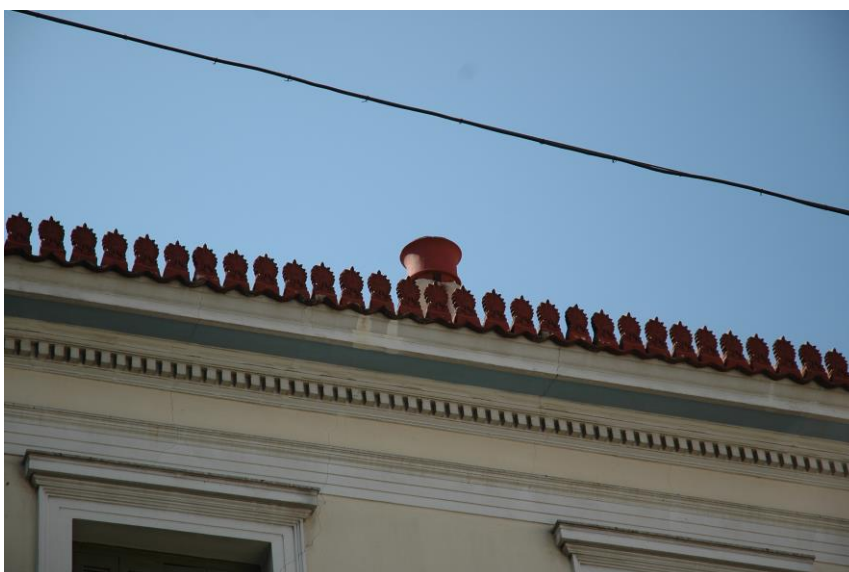
Εικόνα 3.3.2.2 Λεπτομέρεια ακροκέραμων, πρόσφατα αντικατεστημένων, βόρεια όψη
