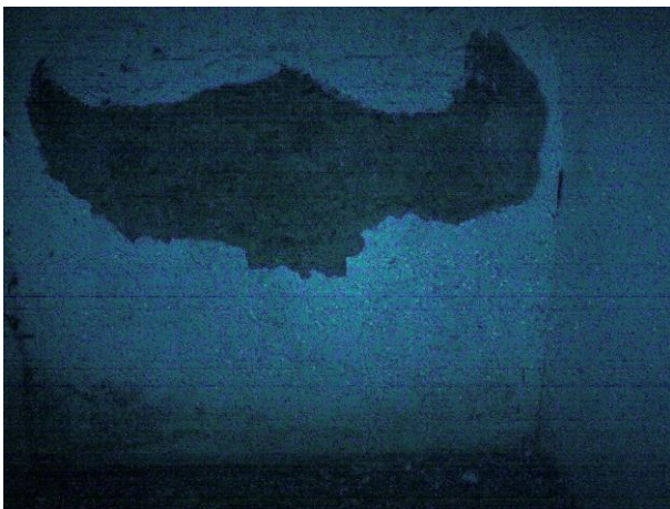
Περιοχή θερμογραφήματος 24 – Καμάρα του Υπογείου κοντά στη σκάλα μετά τη δειγματοληψία
