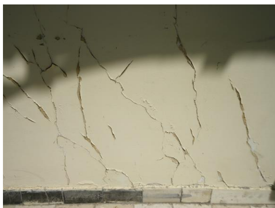
Εικόνα 3.3.2.9 Νότια όψη, εξωτερικά, 1 ος όροφος σε χαμηλό ύψος
