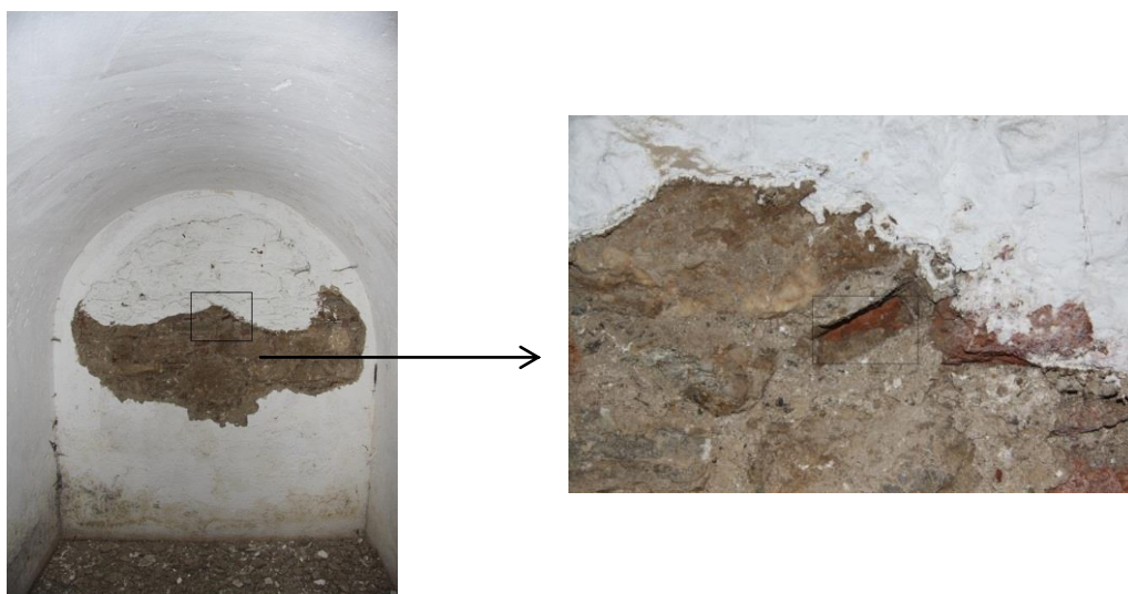
Θέση δειγματοληψίας 1 Υπογείου – ανατολική τοιχοποιία
