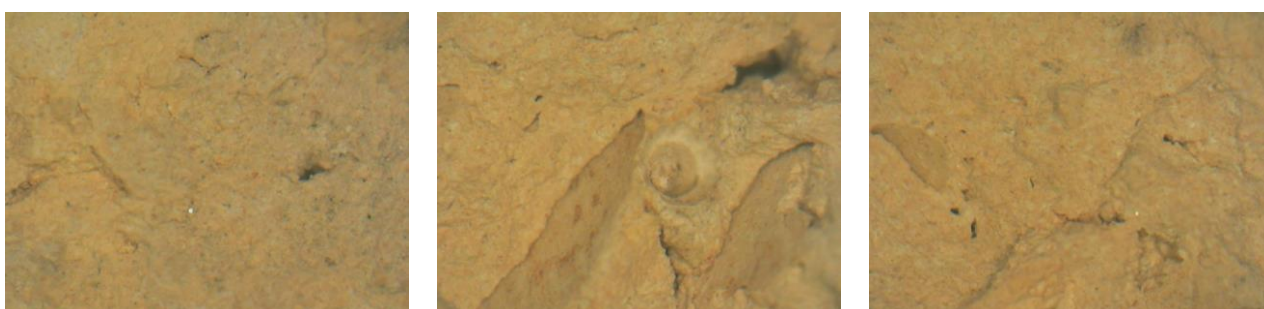
D22_cy: Κίτρινος οπτόπλινθος θέσης 2 2 ου ορόφου x50, x50, x50
