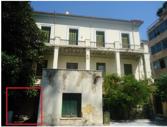
Τοιχοποιία Ισογείου όπου εφαρμόστηκε GPR
