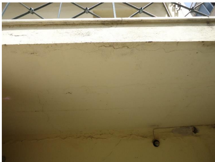
Εικόνα 3.3.2.8 Δάπεδο μπαλκονιού 1 ου ορόφου, νότια όψη
