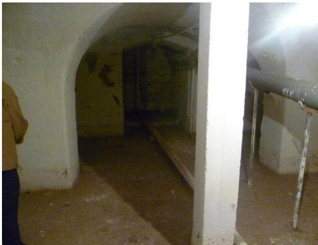
Εικόνα 3.3.2.16 Υπόγειο, νότιος προσανατολισμός
