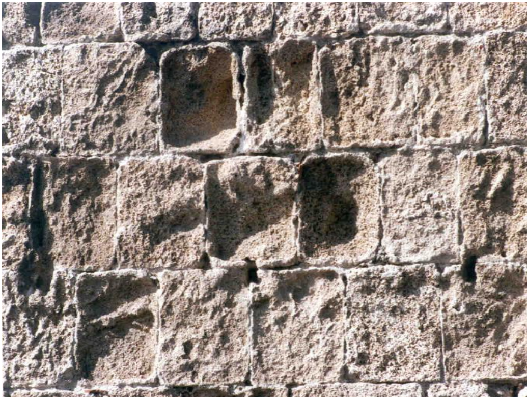
Σχήμα 7: Τμήμα του τοίχους της μεσαιωνικής πόλης της Ρόδου, στο οποίο είχαν χρησιμοποιηθεί ασύμβατα τσιμεντιτικά κονιάματα ως υλικό αποκατάστασης. Παρατηρούμε ότι τμήματα έχουν αποσπαστεί, δημιουργώντας κοιλότητες [18].
