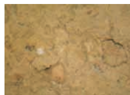
Ασβεστοπηλοκονίαμα (FOM, x50), εσωτερική τοιχοποιία κτηρίου, νότια όψη, 1 ος όροφος
