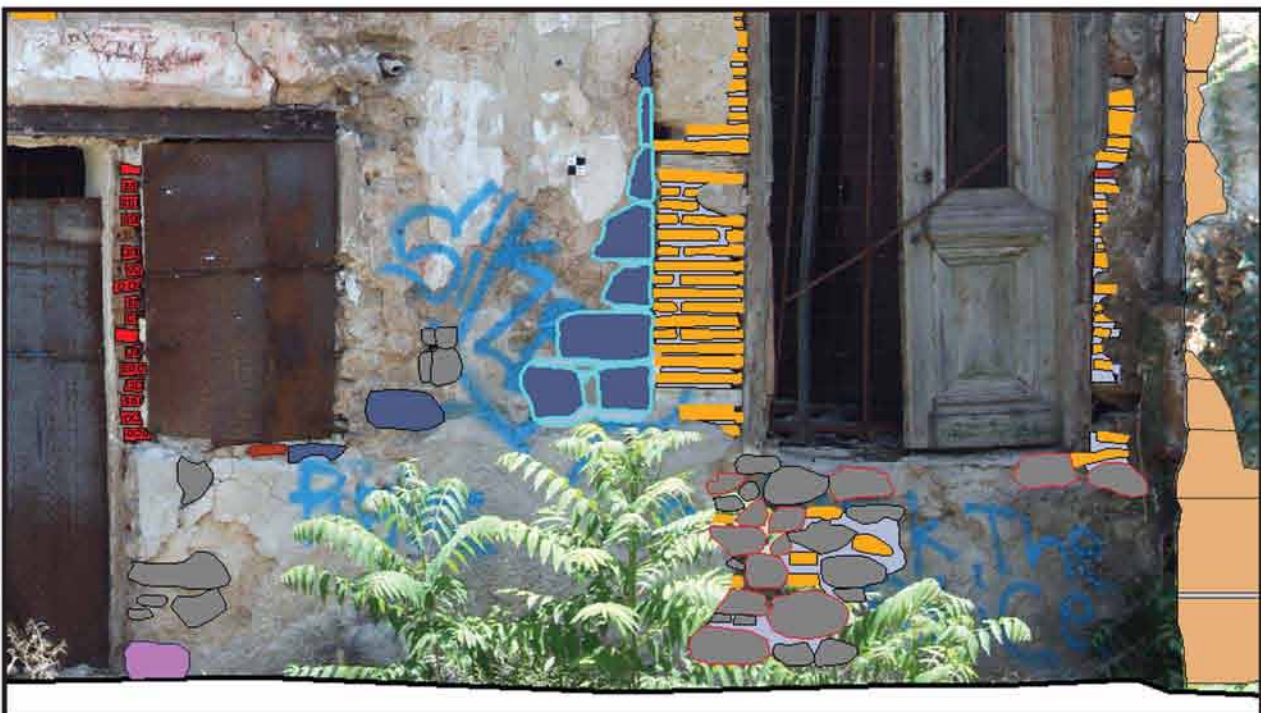
Δυτική Όψη, ΝΔ Γωνιόλιθοι [ΒΔ μεταγενέστερη Οικοδομική Φάση]
