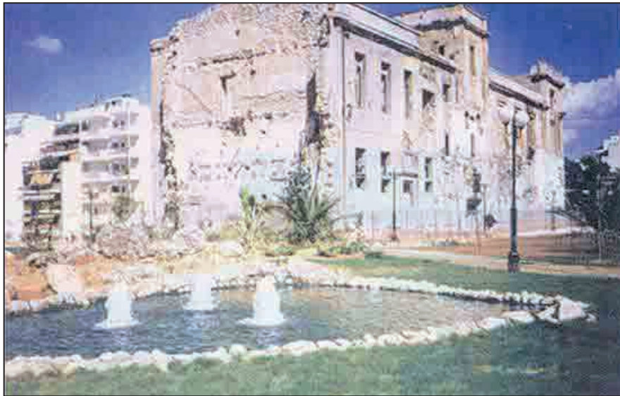
Άποψη από τις ζημιές που προκάλεσε ο σεισμός του 1999 στο πλέον εργοστάσιο ΦΙΞ στα Πατήσια [57].
