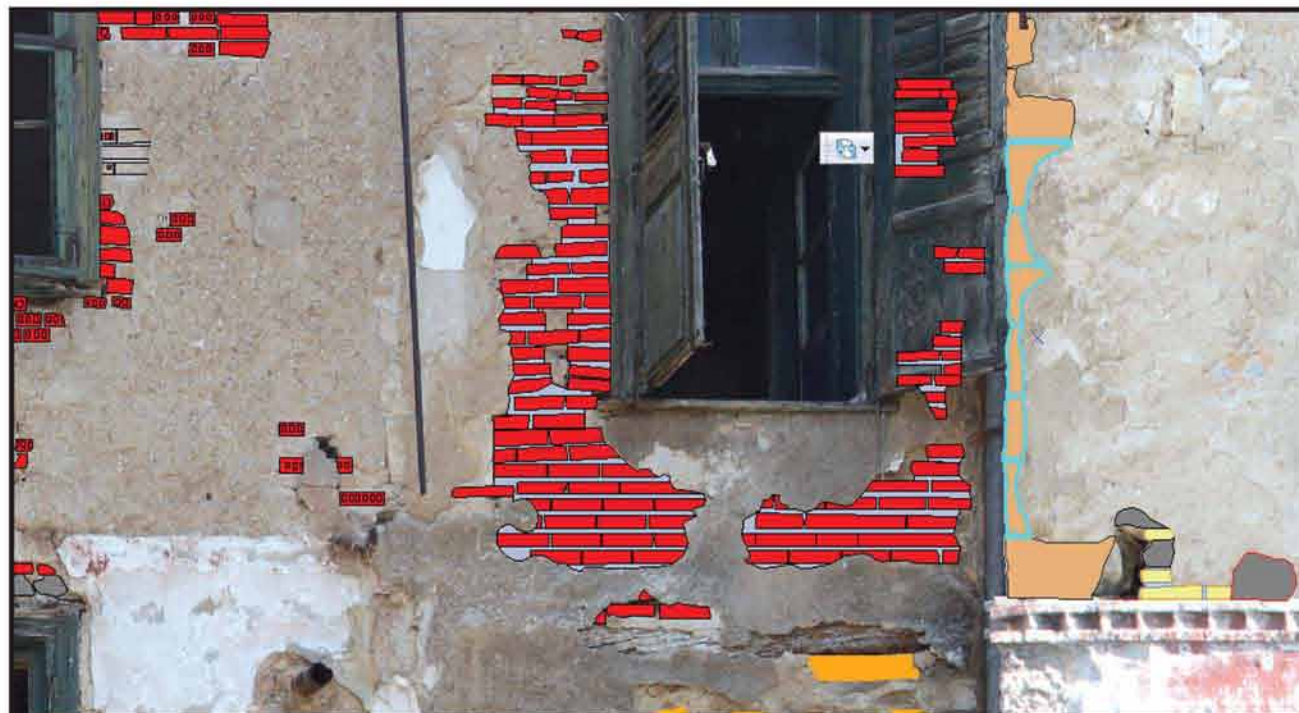
Δυτική Όψη, ΒΔ Γωνιόλιθοι 1ου ορόφου [ΝΔ μεταγενέστερη Οικοδομική Φάση]
