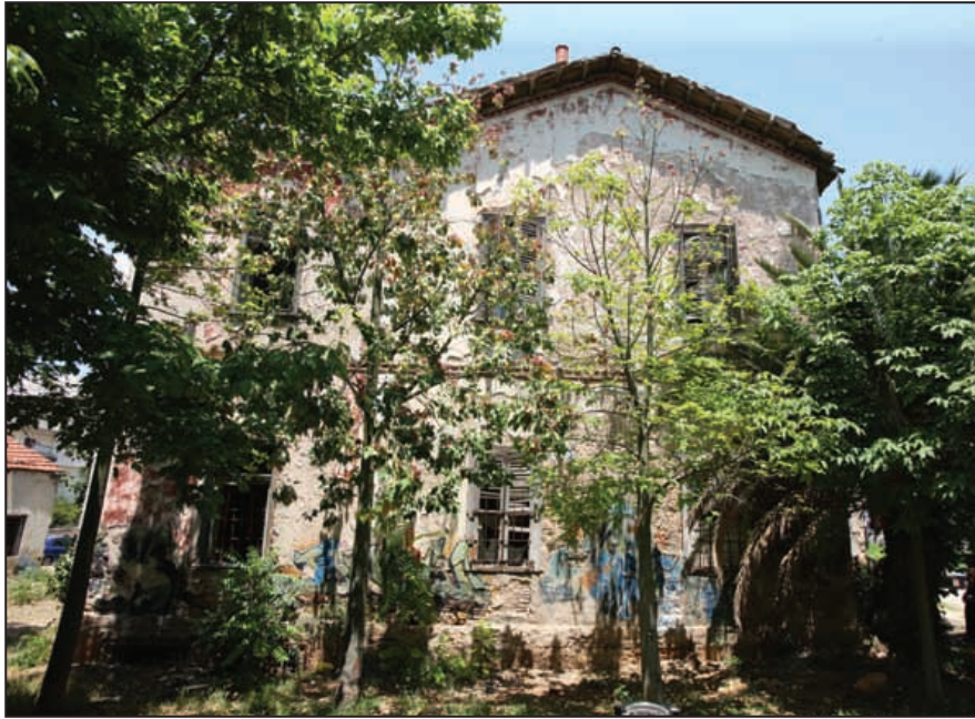
Φωτογραφικές Λήψεις από την Νότια όψη για τη χρήση φωτογραμμετρικών διαδικασιών αναγωγής.
