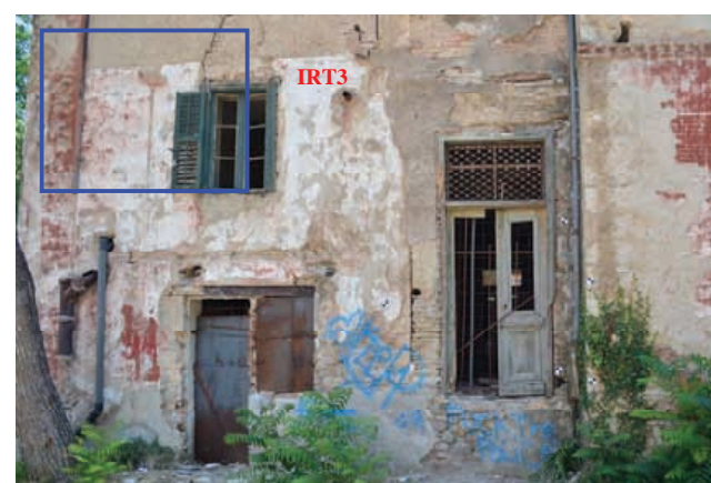
Τρίτη οικοδομική φάση, δυτική όψη, περιοχή εφαρμογής θερμογραφίματος IRT3
