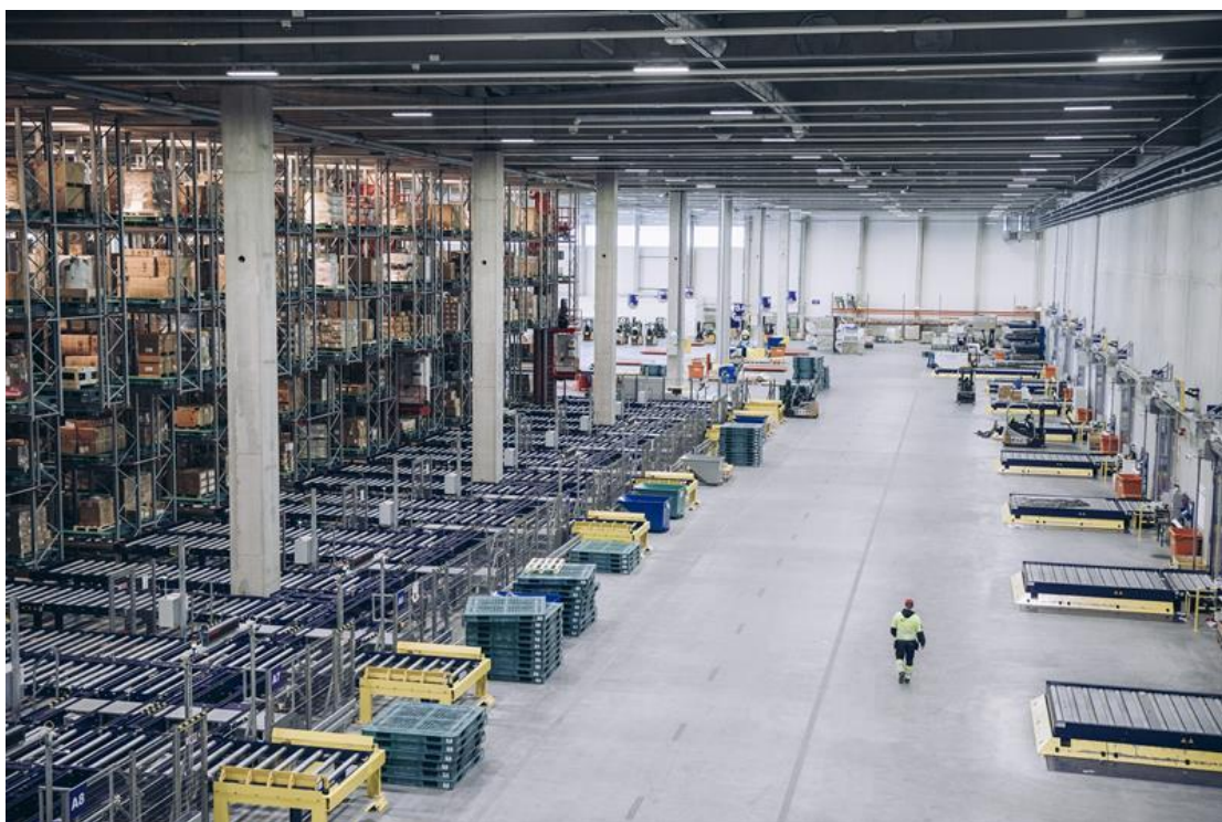
Εικόνα 3.12: Εμπορευματικός σταθμός, Ντουμπάι (πάνω), Εμπορευματικός σταθμός "Finnair Cargo Cool Nordic Hub", Ελσίνκι (κάτω)
