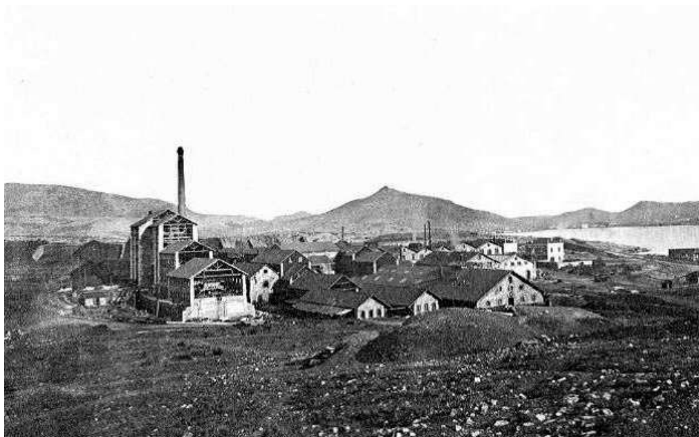
Σχήμα 4.7: Φωτογραφία του 1895 των εγκαταστάσεων της Γαλλικής Εταιρείας Μεταλλείων Λαυρίου. Ολόκληρο το συγκρότημα της φωτογραφίας, σώθηκε σχεδόν ακέραιο και αναστηλώθηκε από το ΕΜΠ το 1996-2001. Σήμερα στεγάζει το Τεχνολογικό-Πολιτιστικό Πάρκο Λαυρίου (Κ. Κονοφάγος 1980)
