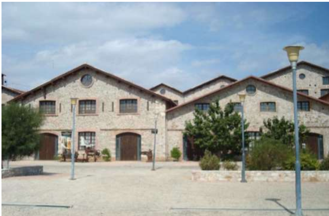
Σχήμα 4.8: Το συγκρότημα Μηχανουργείου μετά την αποκατάσταση του
