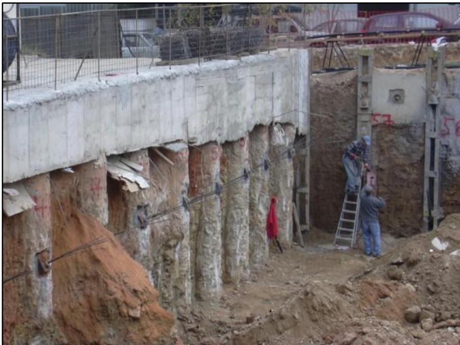
**Σχήμα 1.1** Τοίχος αντιστήριξης με πασσάλους
