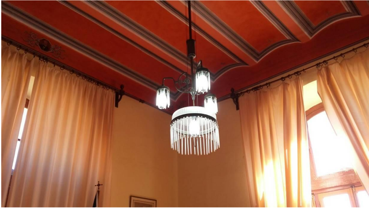
Εικόνα 9: Φωτιστικό σώμα με 4 λαμπτήρες LED ισχύος 30W
