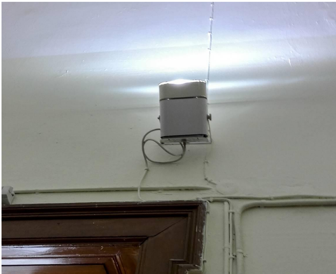
Εικόνα 21: Φωτιστικό σώμα μεταλλικών αλογονιδίων (MH) 150 W σε χώρο γραφείου
