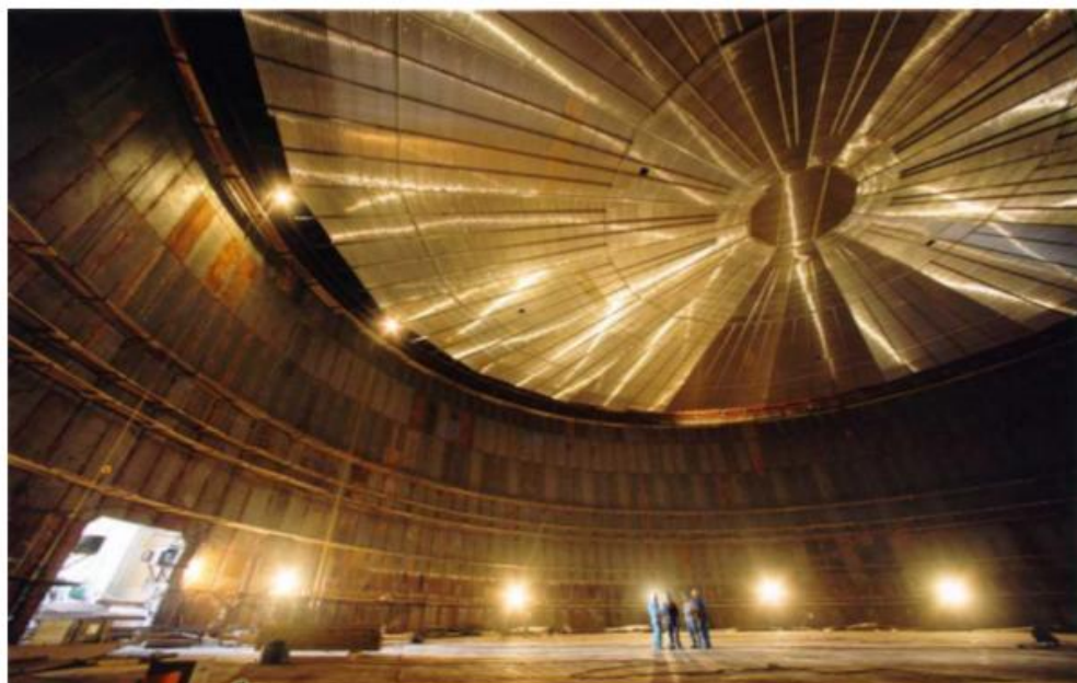
Εικόνα 31: Εσωτερικό δεξαμενής αποθήκευσης LNG [11]
