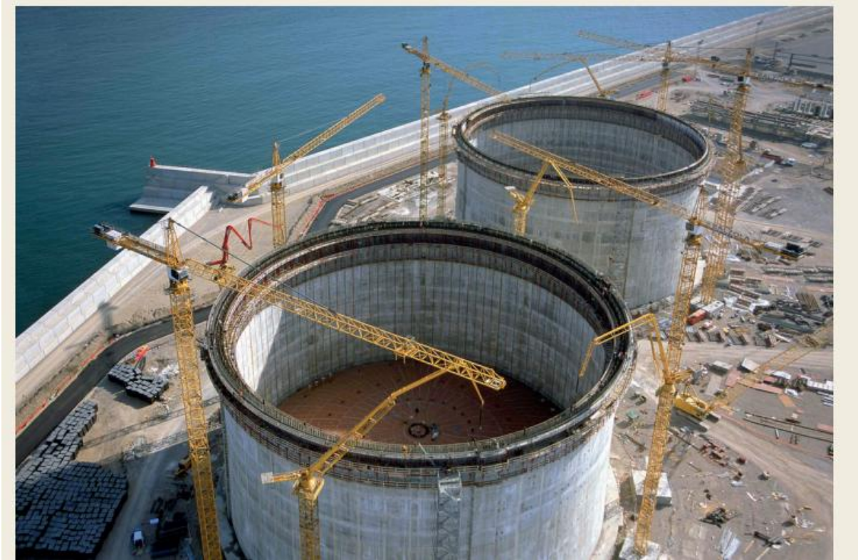
Εικόνα 32: Κατασκευή δεξαμενών πλήρους συγκράτησης [63]
