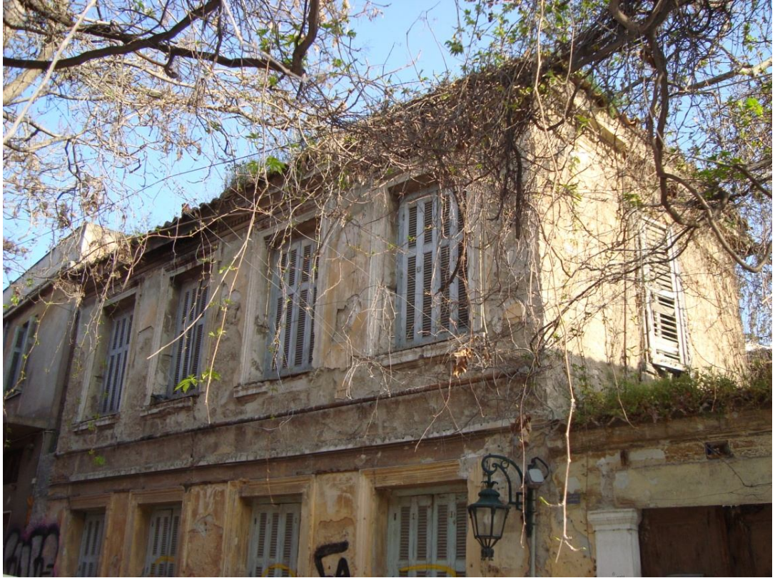
Φωτ.1 : Πρόσοψη του κτιρίου επί της οδού Κλάδου.
