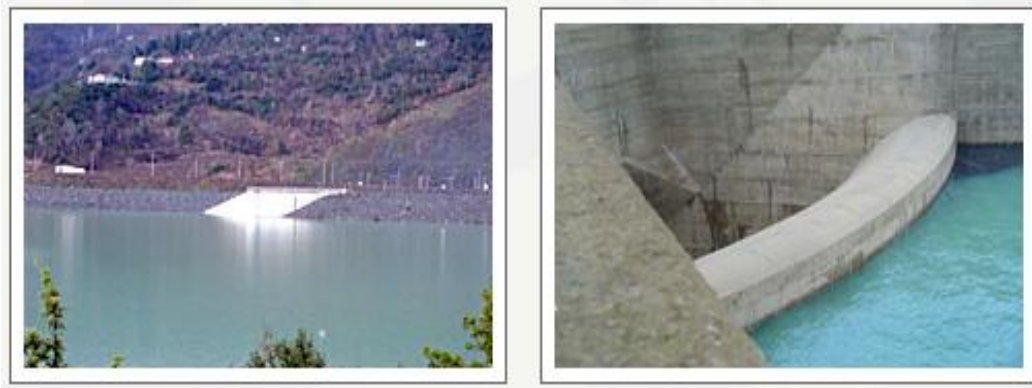
Σχήμα 3.4 : Υπερχειλιστής Φράγματος Ευήνου [Δήμος Πλατάνου] Figure 3.4 : Spillway of Dam Evinos [Platanos]
