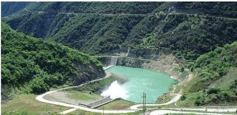
Σχήμα 3.5 : Σήραγγα εκτροπής και εκκένωσης Φράγματος Ευήνου [Δήμος Πλατάνου] Figure 3.5 : Tunnel diversion and discharge utilities of Dam Evinos [Platanos]
