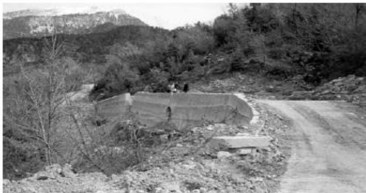
Σχήμα 3.8 : Άποψη του σπασμένου τεχνικού [ΕΥΔΑΠ] Figure 3.8 : View of broken technical work [ΕΥΔΑΠ]
