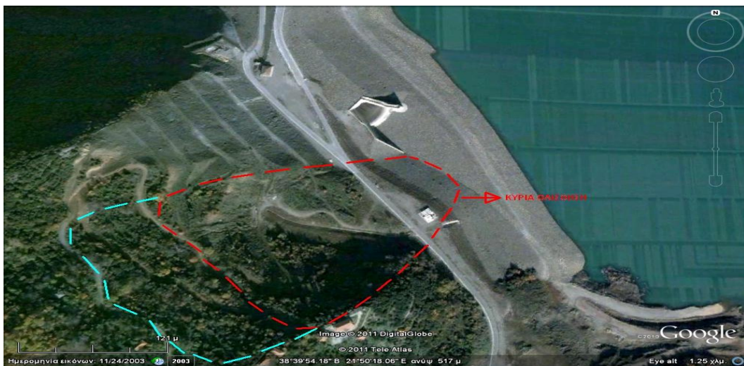
Σχήμα 4.2 : Περιοχή της κατολίσθησης “1993” [ Google Earth] Figure 4.2 : Location of the landslide “1993” [Google Earth]
