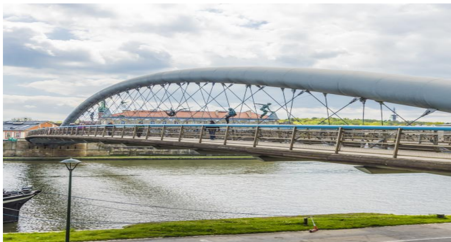
Εικόνα 1.3: Πεζογέφυρα Bernatka (Πολωνία, 2010)
