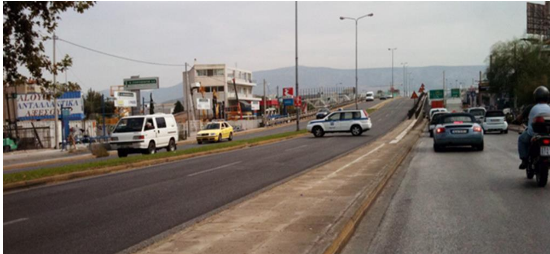
Εικόνα 1.12: Απουσία προστατευτικών κυκλιδωμάτων
