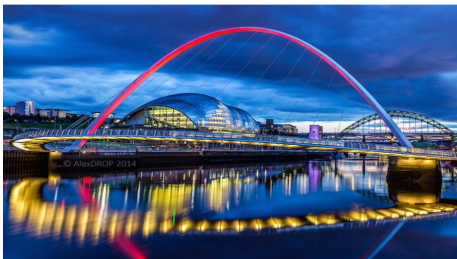
Εικόνα 1.4: Πεζογέφυρα Gateshead Millennium (Αγγλία, 2001)
