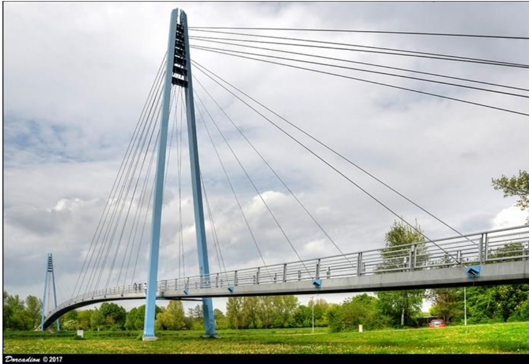
Εικόνα 1.9: Πεζογέφυρα Celakovicka zavesena lavka (Τσεχία, 2014)
