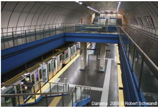
Εικόνα 2.12: Σταθμός Darsena- Γένοβα
