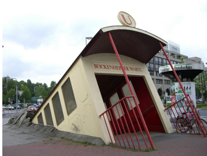
Εικόνα 1.2: Είσοδος του μετρό στην πόλη της Φραγκφούρτης, σταθμός Bockenheimer Warte Πηγή: http://twistedstifter.com/2013/03/bockenheimer-warte-subway-entrance-frankfurt-germany/
