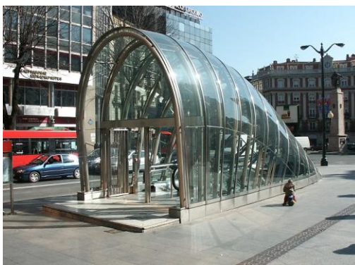
Εικόνα 2.9: Είσοδος του μετρό στο Μπιλμπάο
