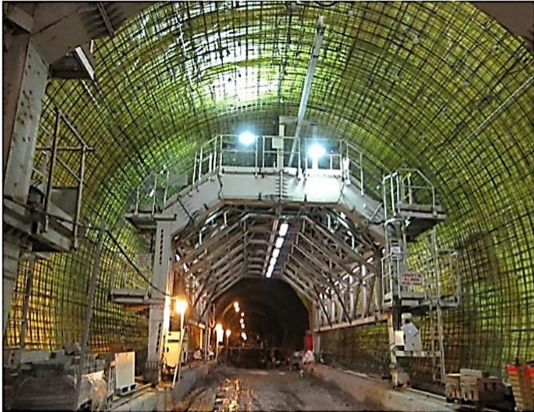
Σχήμα 2.10 γ: Τοποθέτηση οπλισμού με χρήση ειδικού κριώματος, (Σοφιανός Α.Ι, 2018).
