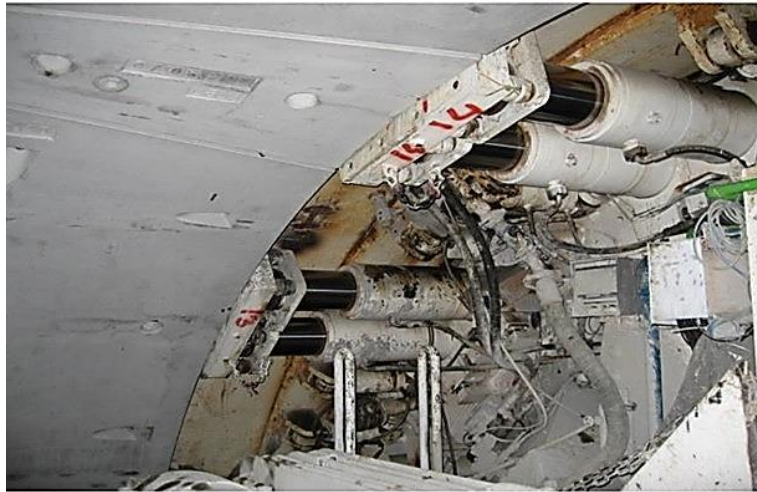
Σχήμα 2.15.5 β: Πέδιλα έδρασης των εμβόλων ώθησης του TBM στο τελευταίο προκατασκευασμένο δακτύλιο της μόνιμης επένδυσης (Αττικό Μετρό,2011)
