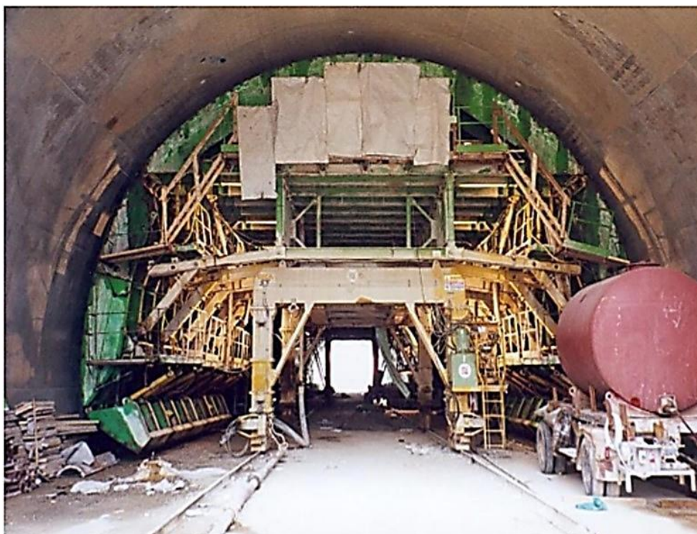
Σχήμα 2.10 δ: Σπαστός μετακινούμενος μεταλλότυπος, (Σοφιανός Α.Ι, 2018)
