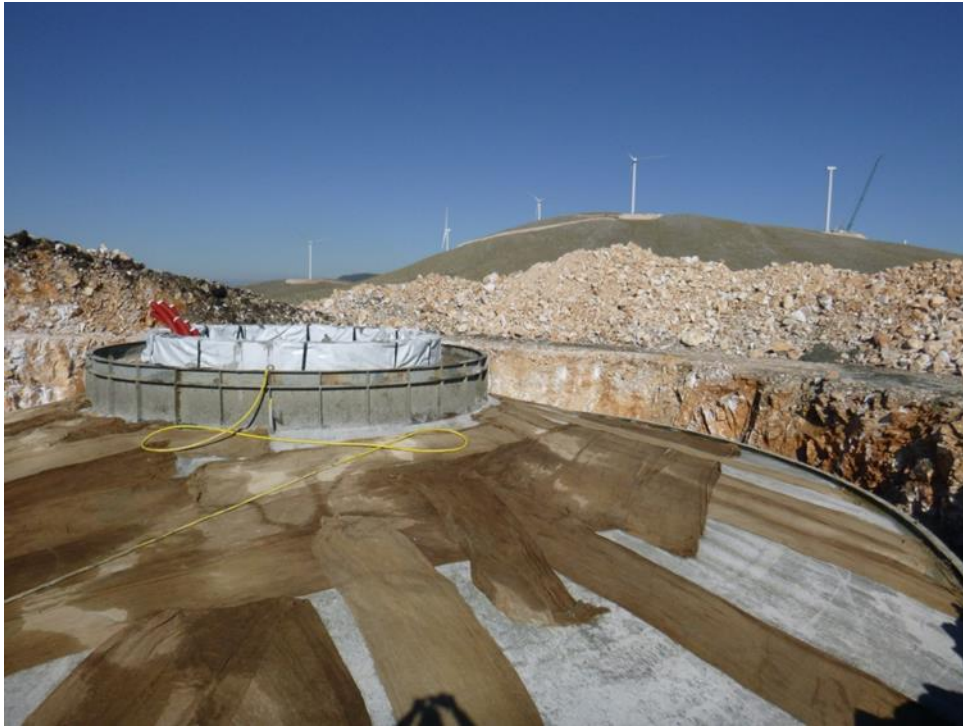
Φωτογραφία 1: Προστασία σκυροδέματος βάσης ανεμογεννήτριας
