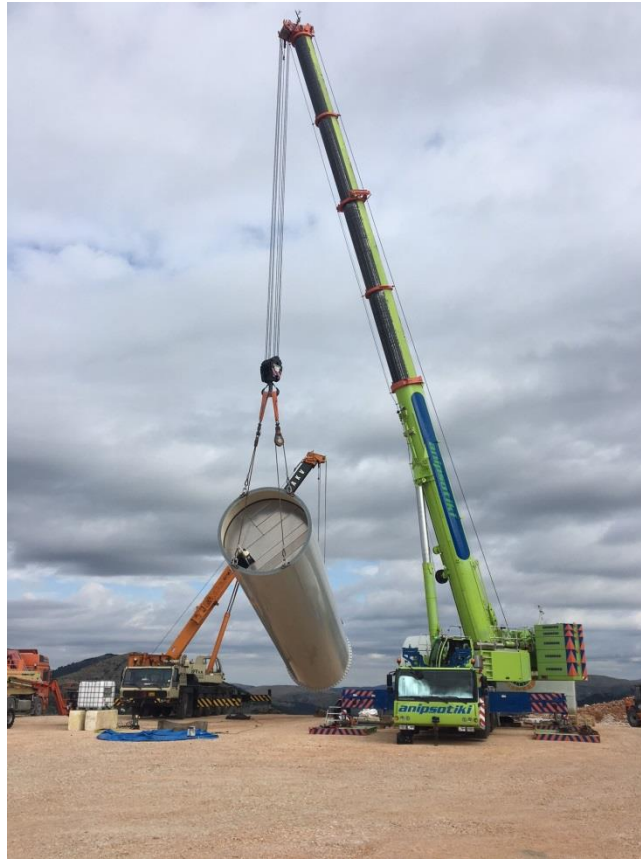
Φωτογραφία 3: Ανέγερση κάτω τμήματος πυλώνα WTG
