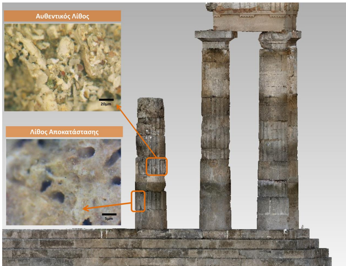
Εικόνα 42: Συσχέτιση αποτελεσμάτων Μικροσκοπίας Οπτικών Ινών σε επιλεγμένους δομικούς λίθους στον μερικώς ανακατασκευασμένο κίονα στην ανατολική όψη; Αυθεντικός λίθος (30x) και λίθος αποκατάστασης (120 x).
