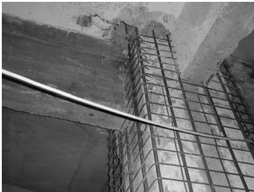
Σχήμα 2. 2 - Μανδύας στην περιοχή κόμβου δοκού – υποστυλώματος
