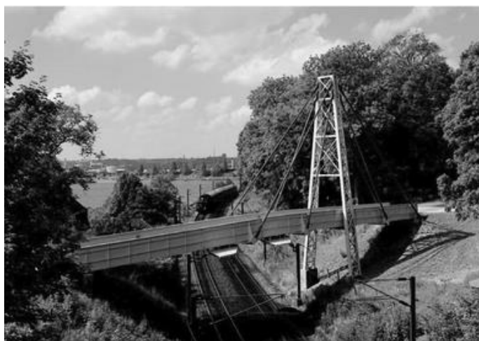
Σχήμα 1.5: Γέφυρα Kolding, εξ'ολοκλήρου κατασκευασμένη από GFRP. (The International Handbook of FRP Composites in Civil Engineering, 2014)
