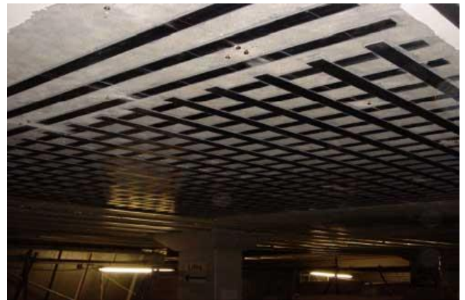
Σχήμα 1.2: FRP σε μορφή ράβδων οπλισμού σκυροδέματος (Correia, 2013)
